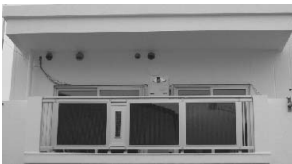
写真 1 手すり一体型ユニット設置状況
