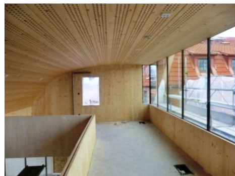
写真 2 木造オフィスビルの内装（スウェーデン）
