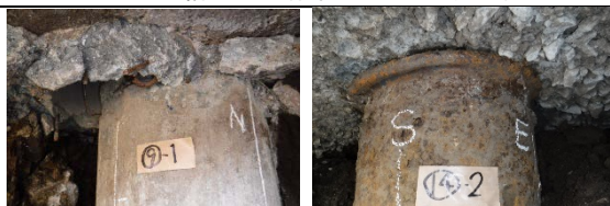
図 1.3 杭被害の事例 (左：既製杭，右：鋼管杭)
