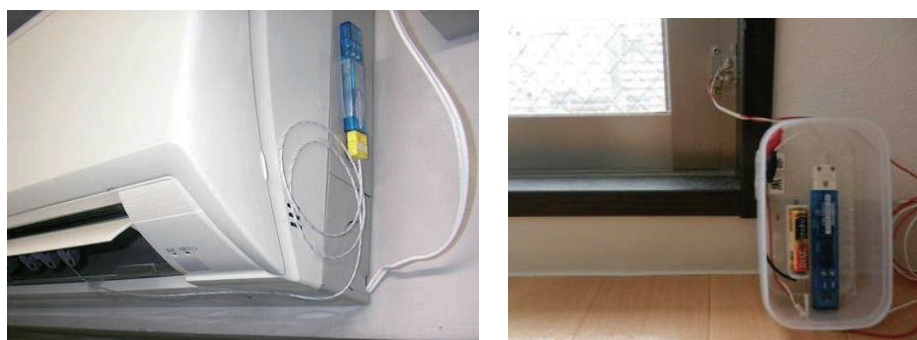
(a) エアコン稼働状況 (b) 窓開閉状況
