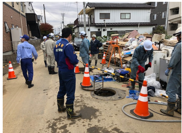
写真-4.18 真空式下水道被害状況確認
