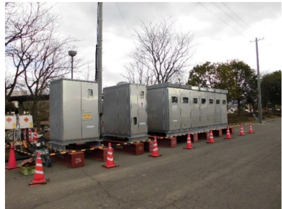
写真-4.9 仮設配電盤
