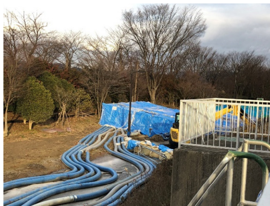
写真-4.7 流入水仮設揚水ポンプ設置状況
