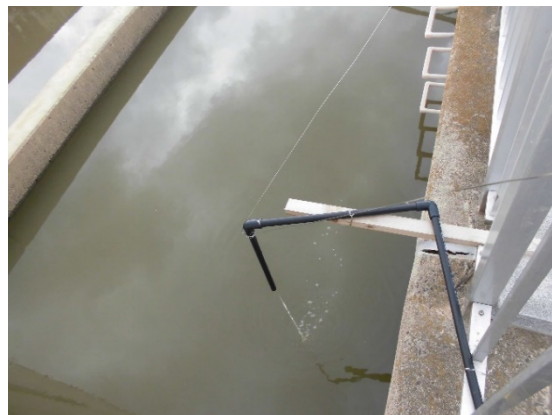
写真-4.10 次亜塩素投入状況
