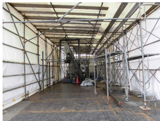
写真-4.11 仮設汚泥処理施設
