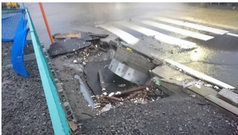
写真-4.22 空気の衝撃圧による管路施設（供用開始前）の被害状況 （提供 静岡市）
