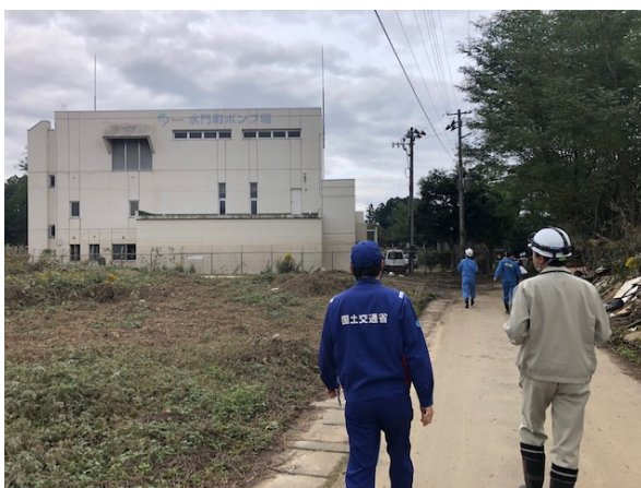
写真-4.19 雨水ポンプ場被害状況確認
