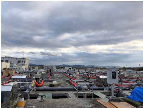
写真-4.8 最初沈殿池分配層仮設状況
