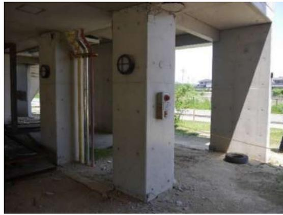
写真 5.3.3 X5-Y3 柱 (曲げ降伏, 損傷度Ⅲ)
