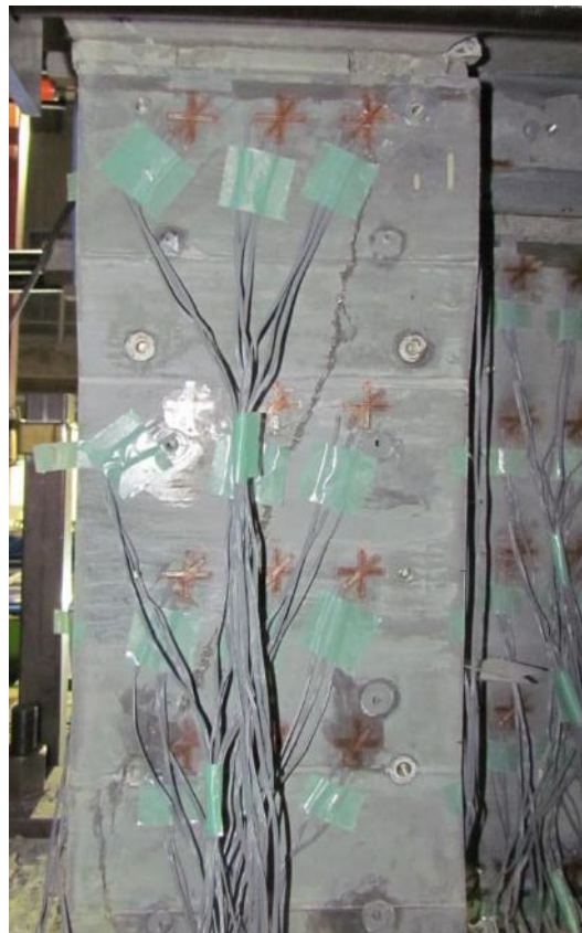
(h) UFC パネルせん断ひび割れ
