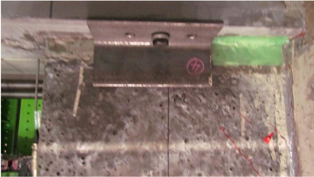
(c) 1/400 時 1C2 袖壁せん断ひび割れ
