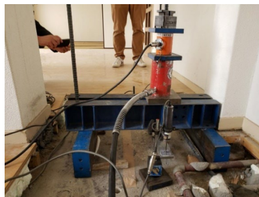
写真 1.3-4 実構造物でのアンカー実験
