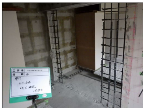
写真 8.2.2-39 壁柱補強用配筋検査
