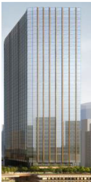
外壁太陽光パネル（スパンドレル部）
