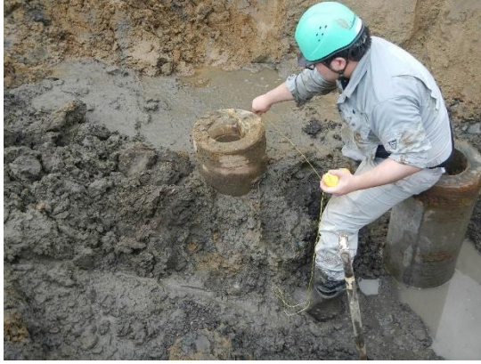
a) 検尺状況（1.5m程度）杭 No. 1
