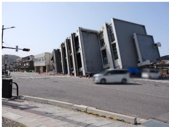
図 2.1.1-2 観測対象建物（A建物）
