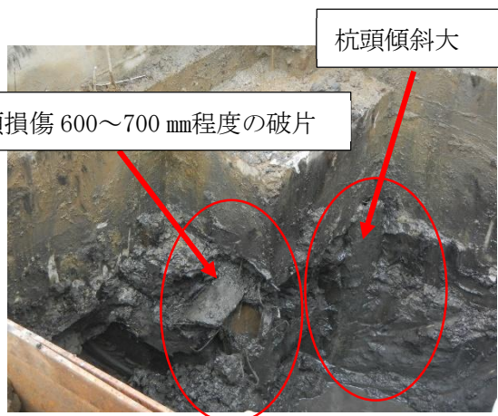
a) 左杭頭損傷大・右杭傾斜大 (①)
