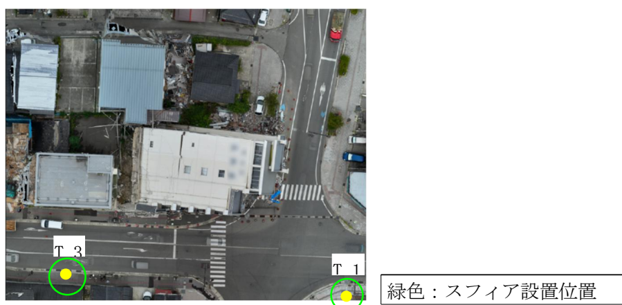
図 2.1.3-5 スフィア設置位置
