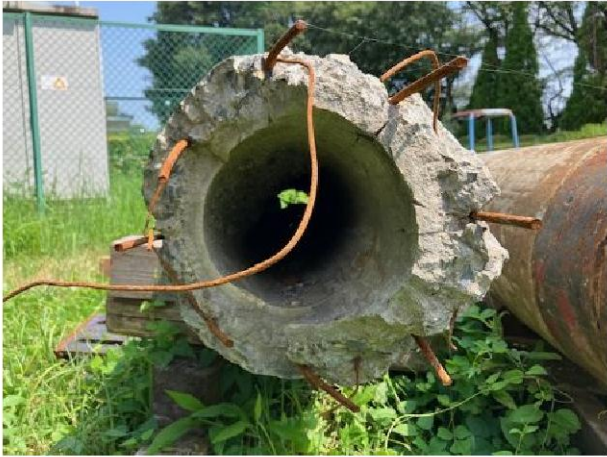
写真 3.1.3-1 採取した杭体
