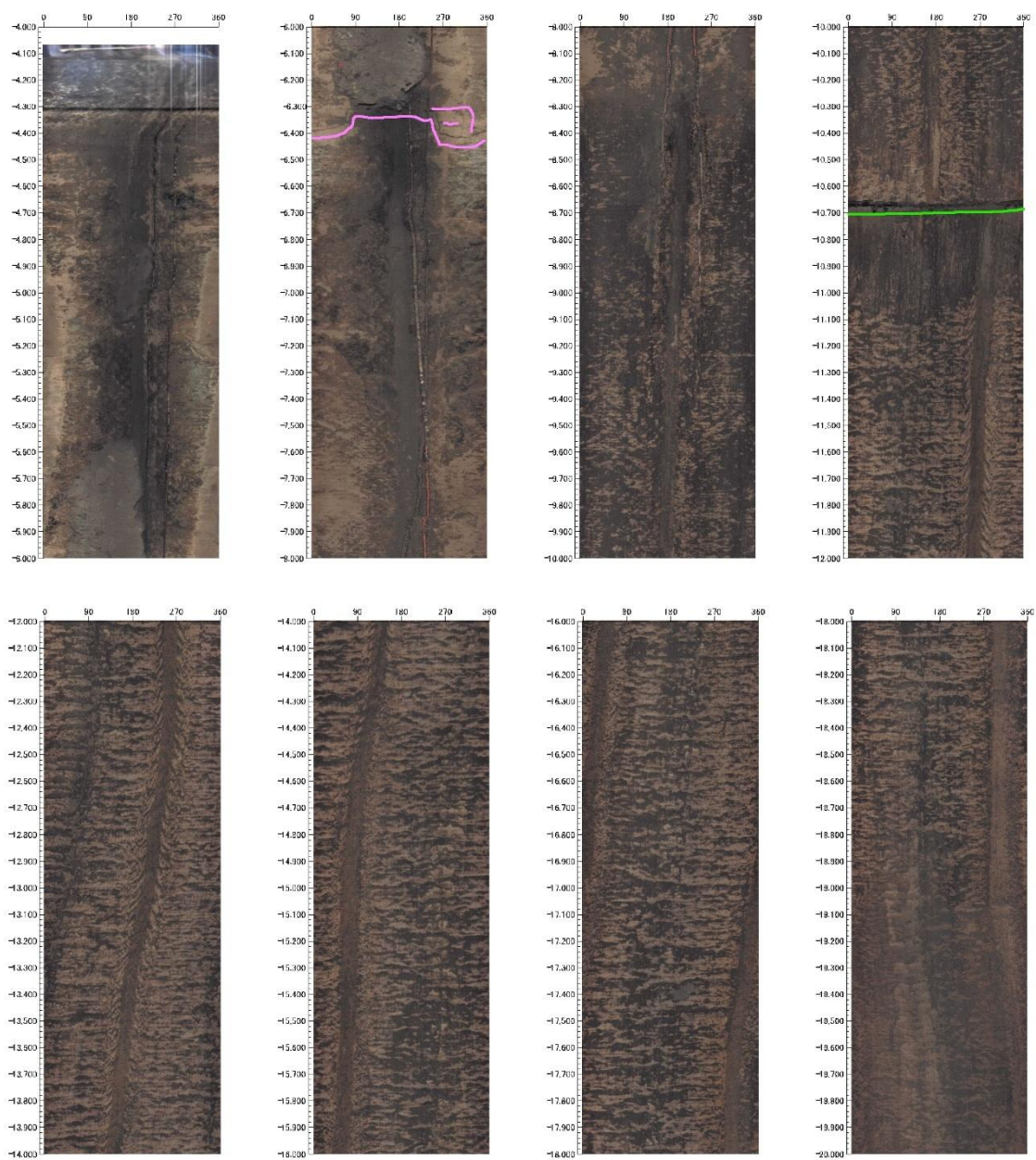
図 3.1.4-23 杭中空部の撮影記録 (X0Y3No. 4 : 杭頭から GL-20.0m まで)
