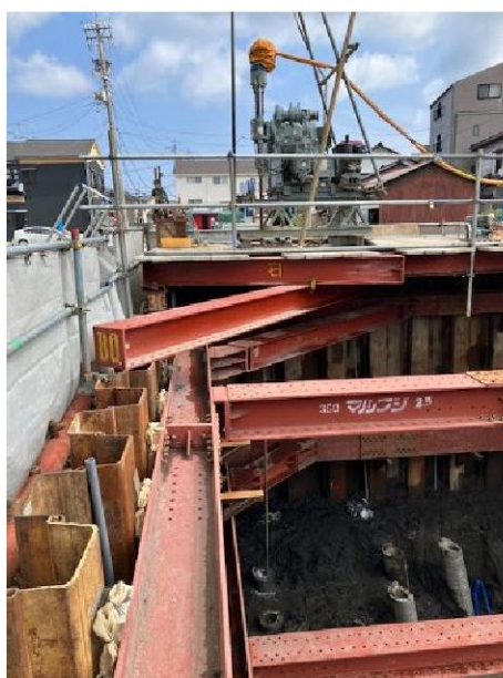
写真 3.1.4-1 杭中空部の土砂排出状況
