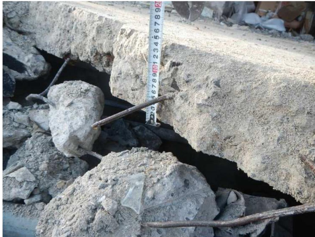
写真 1112-7 Y3 フレーム隣接 PS 壁 壁厚の測定 約 150mm
