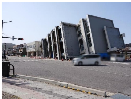
図 2.1.1-2 観測対象建物（A建物）
