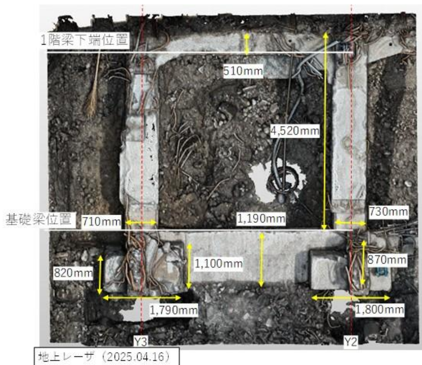
図 2.2.3-39 X2 通り軸立面図の寸法の根拠情報(Y2～Y3 通り)
