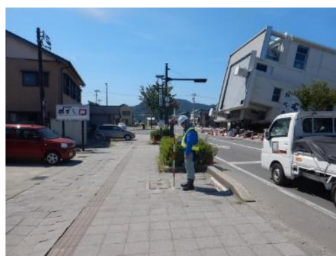
写真 2.2.1-1 水準測量作業状況
