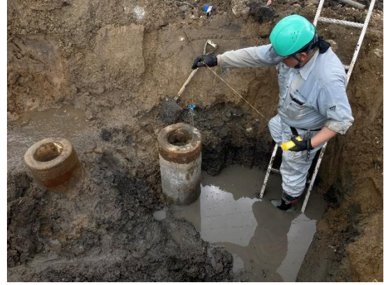
b) 検尺状況（4.5m程度）杭 No. 2
