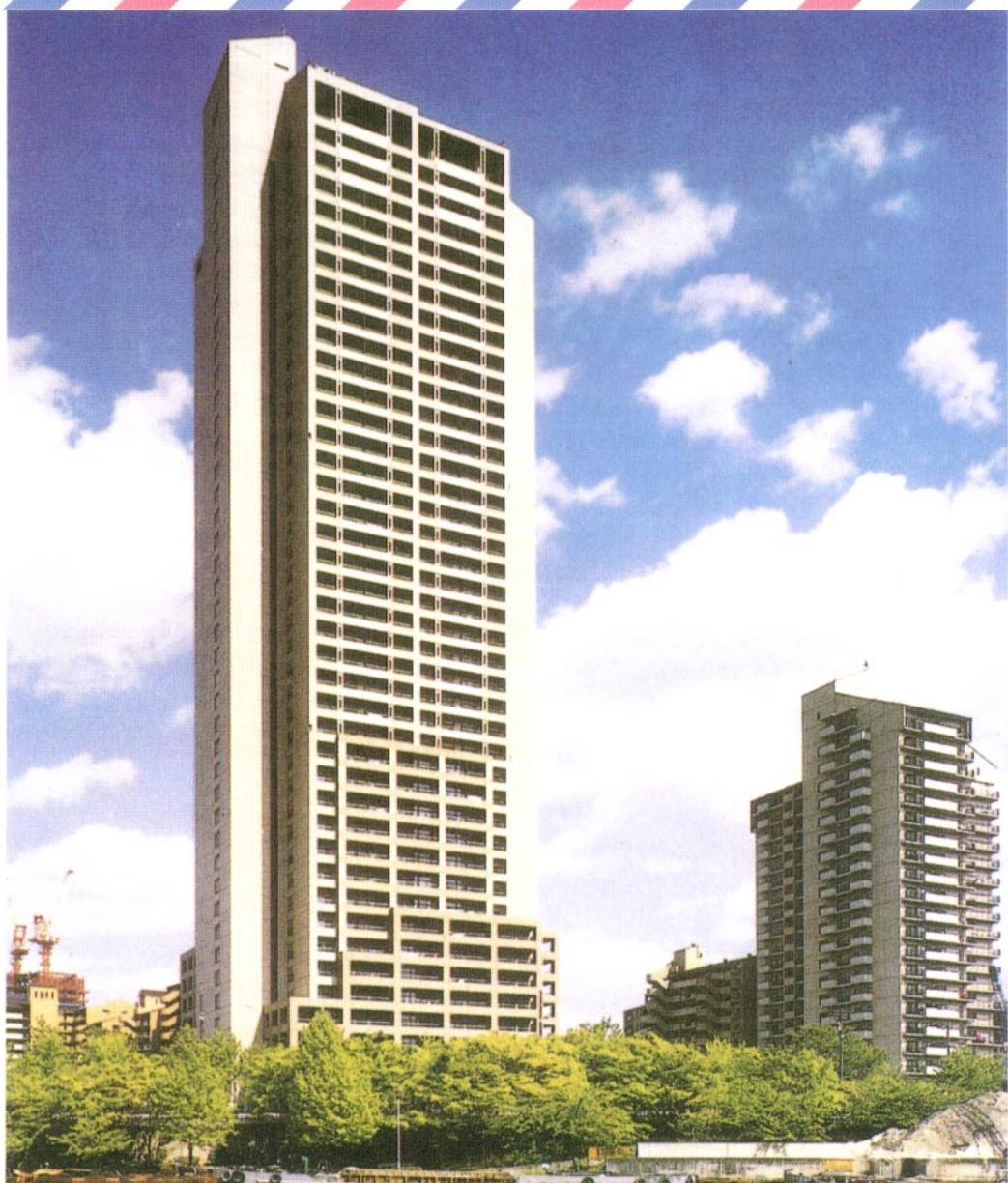
RC造建築では日本最高階のウォータータワープラザ(41階、 $f_c = 420\text{kgf/cm}^2$ 大阪市・桜宮リバーシティ)〔施工・写真提供/(株)大林組〕
