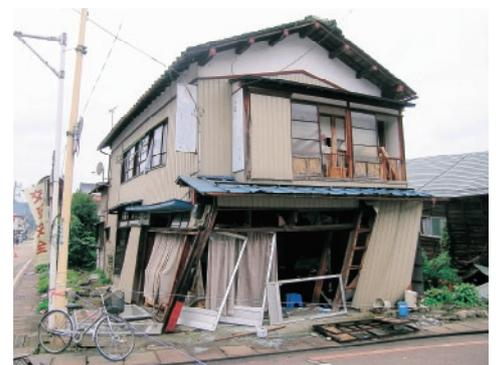
写真2 店舗併用住宅の被害例(川口町)
