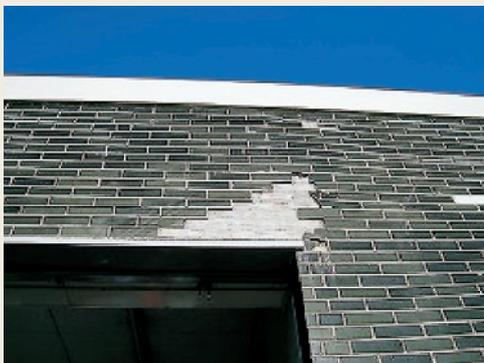
写真5 外壁タイルの剥落の様子
