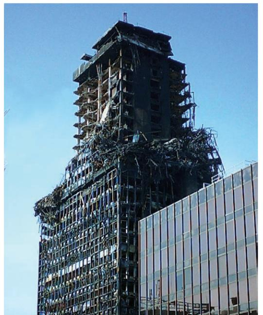
写真2 火災で全焼し上部が大規模に崩壊したスペインの高層ビル
