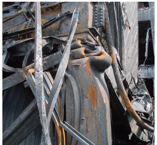
写真1 火災の熱で柔らかくなり大きく変形した工場の鉄骨の柱
