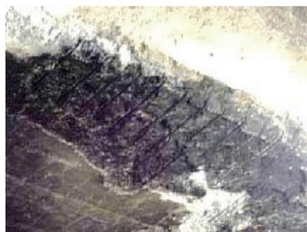
写真4 コンクリート構造部材の爆裂状況
