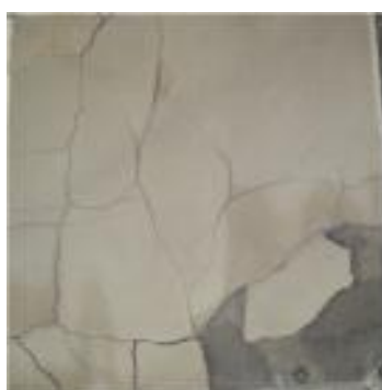
状態Ⅱ：金網より表層のみの剥落
