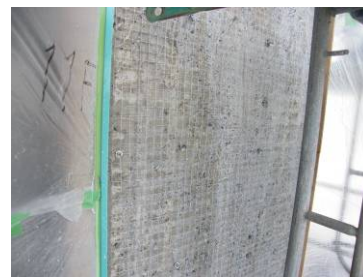
写真-5.6 吸水調整材塗布後
