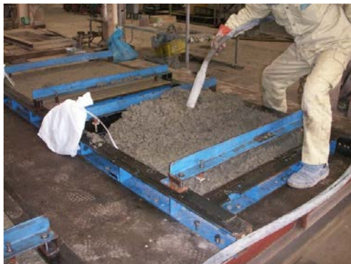
コンクリート打設状況 1
