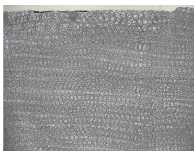
写真-5.2 超高压洗浄(例)
