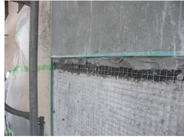
写真-5.23 目地部での塗り継ぎ
