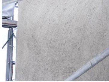
写真-5.22 仕上がり
