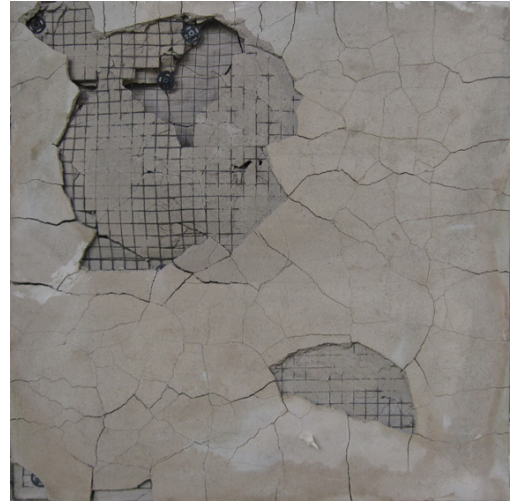
写真-3.2.8 耐火試験後の状況(No. 6) [E3-A] (耐火試験後の損傷状態…IV : 部分的な内部の爆裂)
