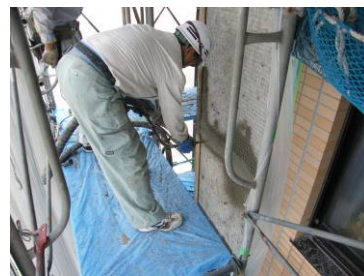
写真-5.15 吹付け施工
