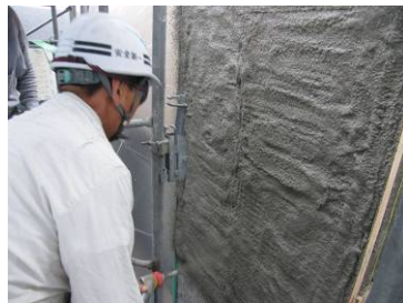
写真-5.18 吹付け施工
