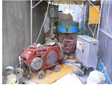
写真-5.7 機材の設置
