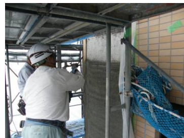
写真-5.17 吹付け施工
