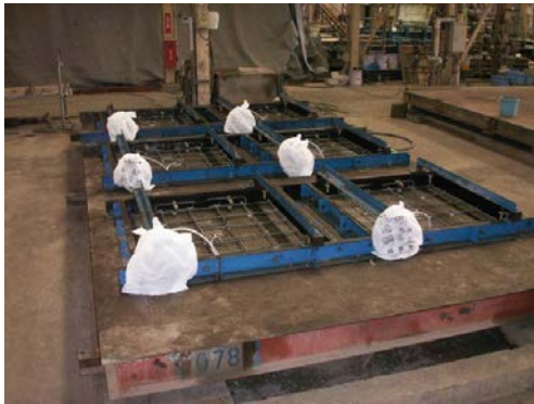
コンクリート打設前型枠状況
