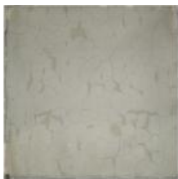
状態Ⅰ：ひび割れ
