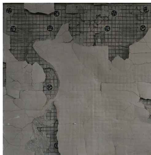
写真-3.2.6 耐火試験後の状況 (No. 5) [P3] (耐火試験後の損傷状態… IV : 部分的な内部の爆裂)
