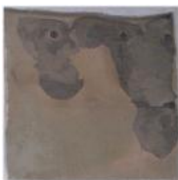
状態Ⅳ：部分的な内部の爆裂
