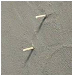
写真-6.1 アンカー孔養生
