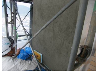
写真-5.21 こて仕上げ
