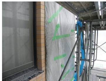
写真-5.24 養生(一例)
