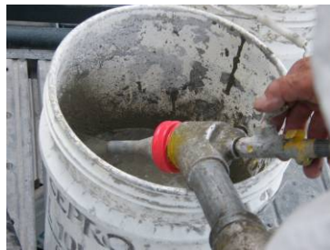
写真-5.14 モルタル量・エア量調整
