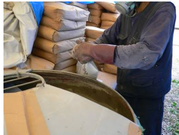
写真-5.10 混和液の投入
