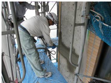
写真-5.16 吹付け施工
