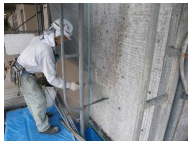
写真-5.5 吸水調整材塗布
