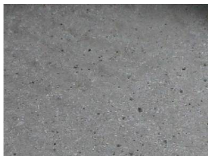
写真-5.1 目荒し後下地状況
