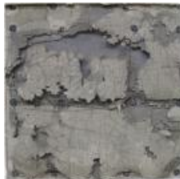
状態Ⅴ：全面的な内部の爆裂
