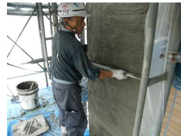
写真-5.19 定木ずり
