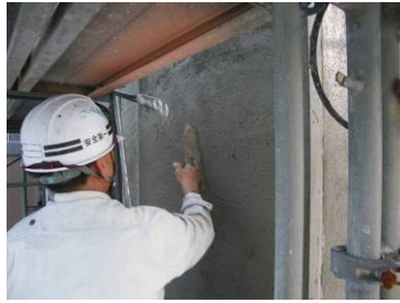
写真-5.20 こて仕上げ
