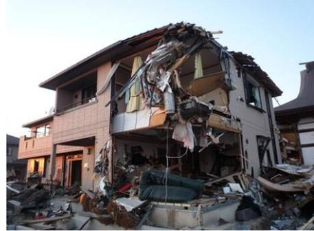
写真 6. 3. 11-4 大きく損傷したものの残存した鉄骨造住宅 (③)
