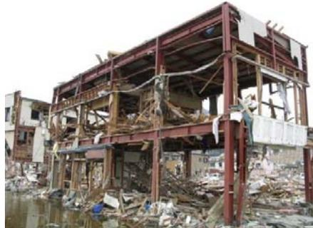
写真 6.5.2-2 残存S造骨組み
