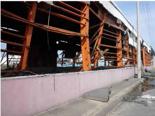
写真 6. 4. 2-25 柱の変形（石巻市）
