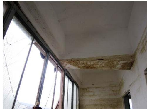
写真 6.4.1-6 建物内部の水の汚れの痕跡
