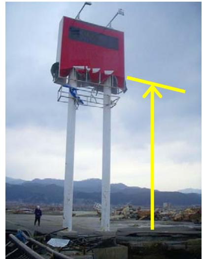
写真 6. 2. 1-9 広告塔の損傷状況
