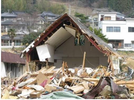
写真 6. 4. 2-13 傾斜した山形ラーメン架構
