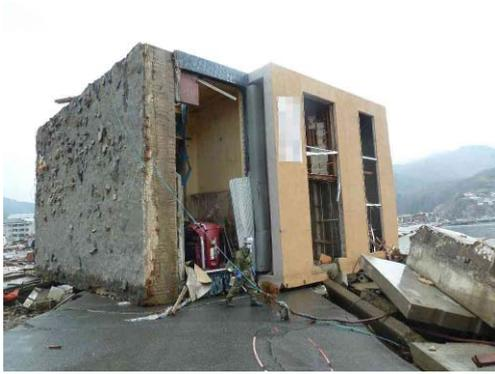
写真 6.4.1-3 3階建て建築物の転倒
