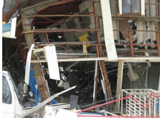
写真 6. 4. 2-14 傾斜した山形ラーメン架構
