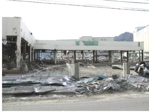
写真 6. 4. 2-19 残存する S 造（釜石市）
