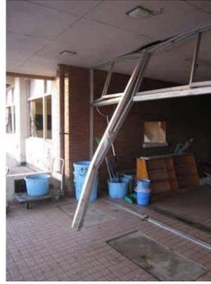
写真 6. 3. 13-3 玄関開口部のアルミフレームの面外変形
