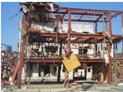
写真 6. 4. 2-12 傾斜した重層建築物（女川町）
