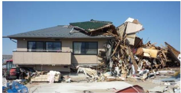
写真 6.3.10-4 1階が層崩壊しても残存している
