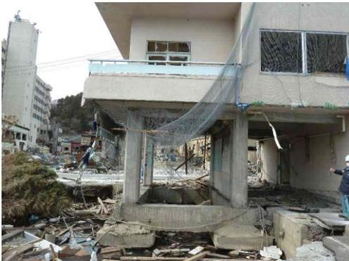
写真 6.4.1-9 洗掘による基礎露出
