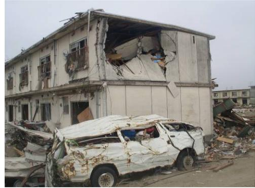
写真 6. 4. 1-14 漂流物の衝突による壁脱落
