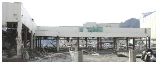
写真 6.5.2-1 残存 S 造骨組み
