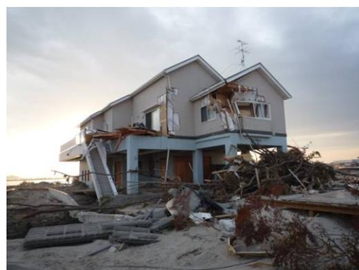
写真 6. 4. 3-7 1階RCピロティー構造の事例
