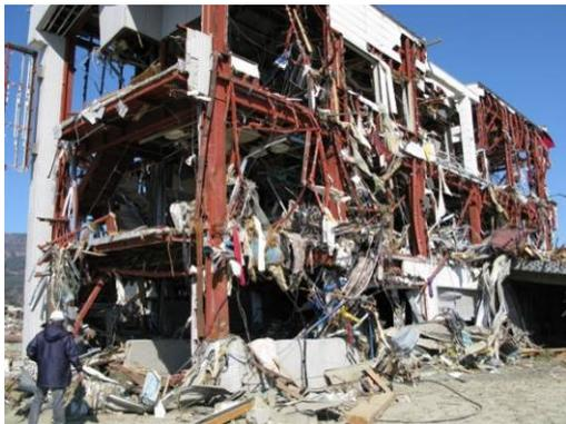
写真 6. 4. 2-15 残存する 3 階建て S 造
