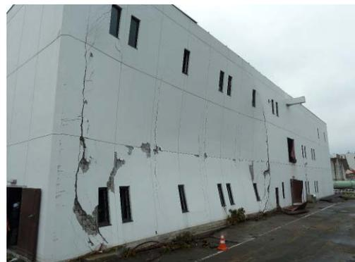
写真 6.4.1-12 床を持たない連層壁の面外破壊
