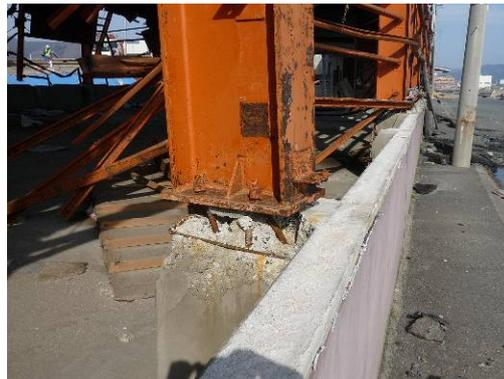
写真 6. 4. 2-26 柱脚部の移動（石巻市）
