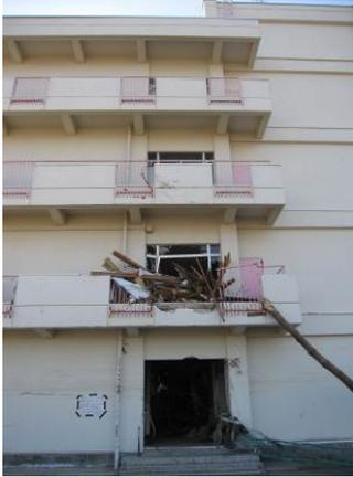
写真 6. 3. 10-15 東側妻面の破損状況 (3 階手摺に損傷が認められる)
