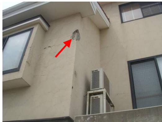
写真 6.3.13-34 2階外壁の衝突痕
