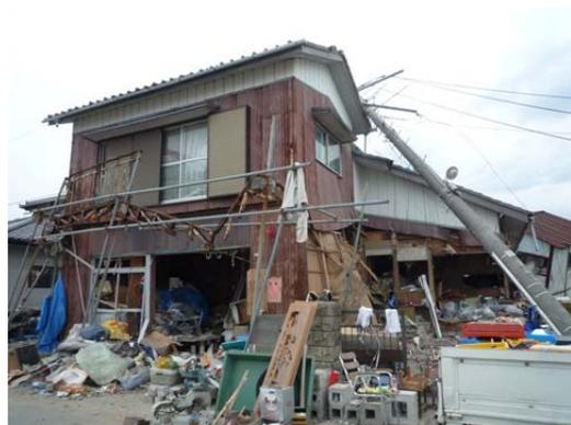
写真 6. 3. 13-18 津波作用方向から見た混構造
