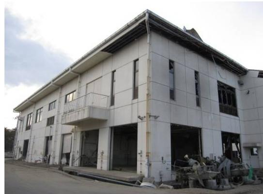
写真 6.3.12-13 屋根及び窓ガラスの損傷
