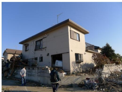
写真 6.3.10-30 残存する RC 造 (パネル) 住宅 (15)
