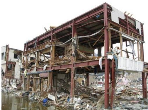
写真 6. 4. 2-17 残存する S 造 (大船渡市) (露出柱脚、1 階途中から日の字断面、2 階床は木製)
