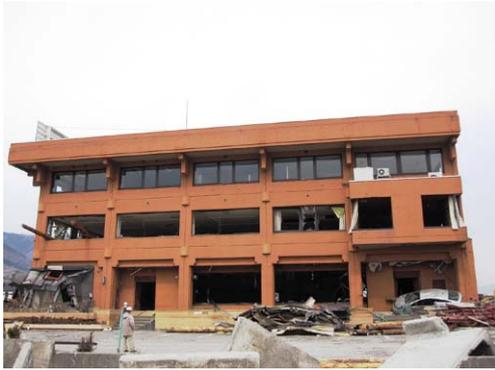
写真 6. 4. 1-13 衝突による非構造部材の損傷
