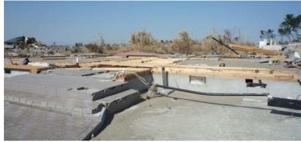
写真 6.3.10-2 基礎と土台が残る被害例
