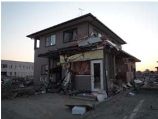
写真 6. 3. 11-5 津波作用方向から見て残存建物の反対側で流失を免れた木造店舗併用住宅 (④)
