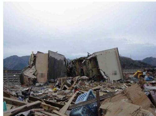
写真 6.4.1-8 集合住宅の転倒(CB造)
