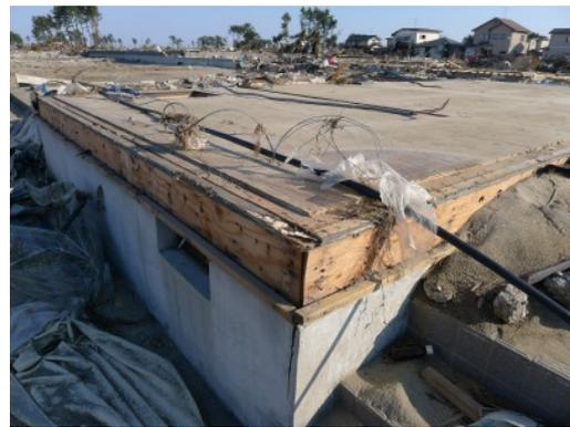
写真 6. 3. 10-22 流失した2×4工法住宅
