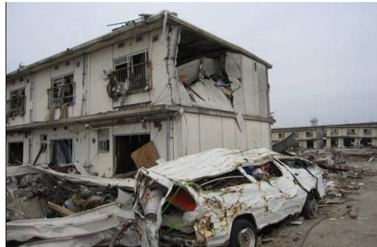
写真 6.3.11-26 2階妻壁の損傷
