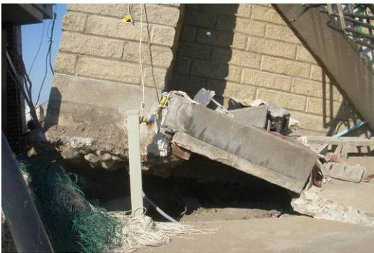
写真 6. 3. 10-11 写真 6. 3. 10-10 の地盤の洗掘状況
