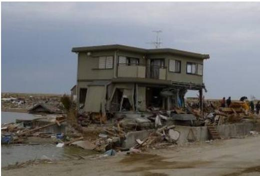
写真 6. 3. 13-25 残存する軽量鉄骨造住宅 (17)
