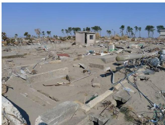
写真 6.4.3-2 上部構造と土台も流失した例
