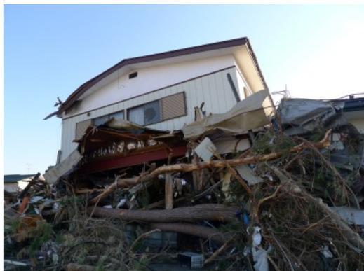
写真 6.3.10-34 全壊状態の H 形鋼梁を有する
