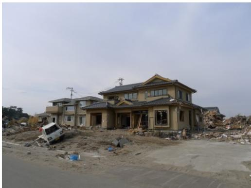
写真 6. 3. 11-56 残存した木造と鉄骨造住宅
