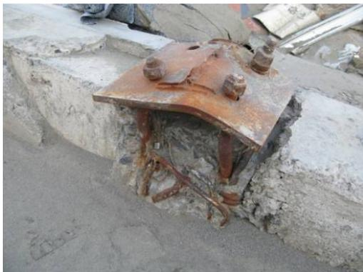
写真 6.4.2-1 柱脚部の破断 (陸前高田市)
