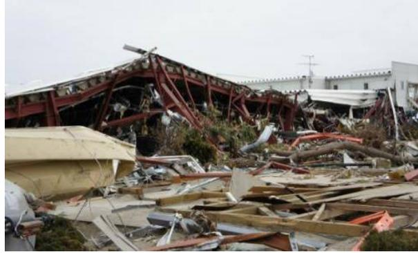
写真 6.3.11-23 写真 6.3.11-22 柱材が大きく変形
