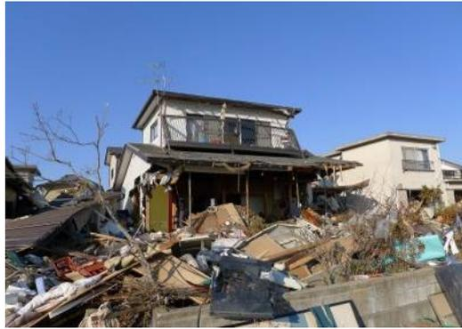
写真 6.3.10-28 1F の損傷の激しい木造
