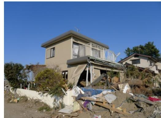
写真 6. 3. 10-26 残存する軽量鉄骨造住宅 (⑫)
