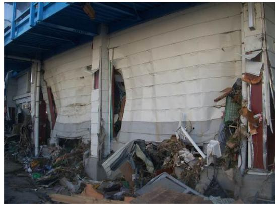
写真 6. 3. 10-18 外壁材の面外変形
