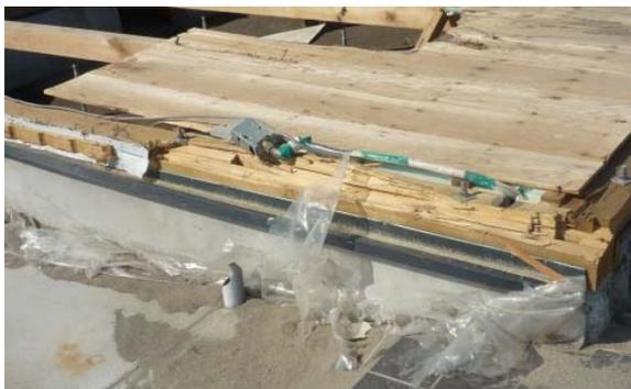
写真 6.3.10-5 土台が割裂した例
