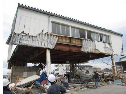
写真 6.3.13-36 2階外壁の破損状況
