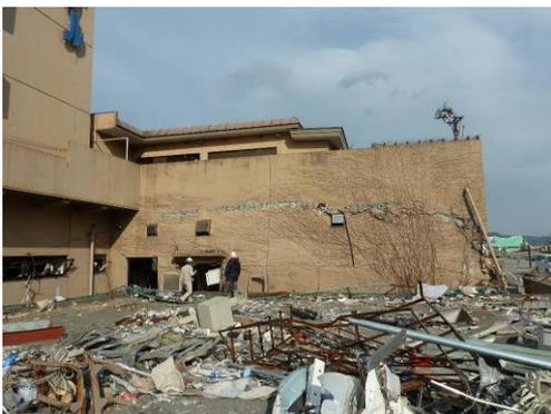
写真 6.4.1-11 非構造壁の面外破壊
