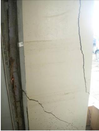
写真 6.3.11-50 壁のひび割れ
