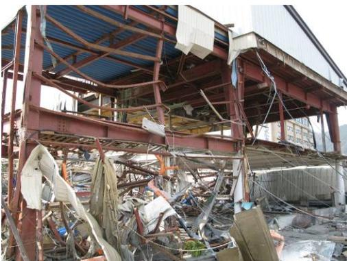
写真 6. 4. 2-27 間柱等の非構造部材の変形（釜石市）
