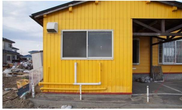
写真6.3.13-2 建物外装材に残る浸水痕
