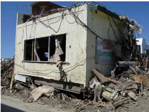
写真 6.4.1-1 2階建て建築物の層崩壊
