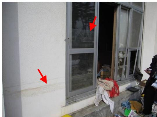
写真 6. 3. 11-64 1階の浸水痕
