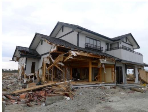
写真 6. 4. 3-6 建築物隅部を流失しつつも残存した事例(1)
