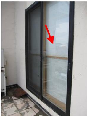
写真 6.3.13-33 2階窓ガラスの浸水痕
