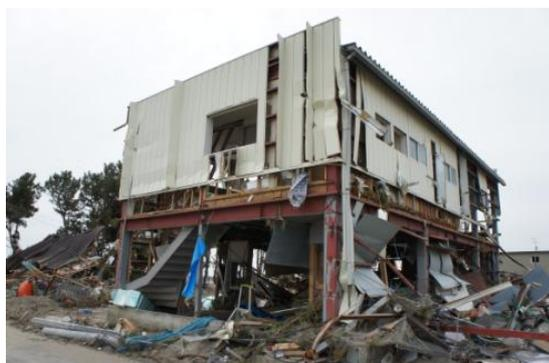
写真 6. 3. 11-21 外装材は損傷しているが構造体は健全な鉄骨造(1)
