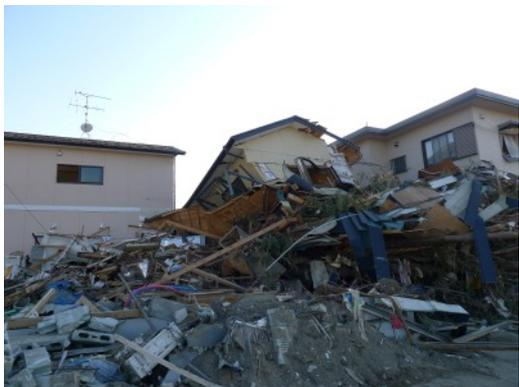
写真 6.3.10-31 損傷の激しい木造
