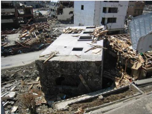
写真 6.4.1-5 4階建て杭基礎建築物の転倒
