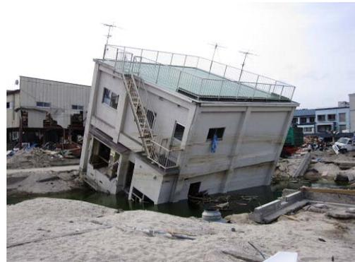
写真 6.4.1-10 洗掘による2階建て建築物の傾斜
