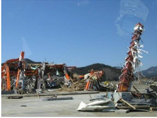
写真 6. 4. 2-3 根巻柱脚の1階柱の残存 (陸前高田市)
