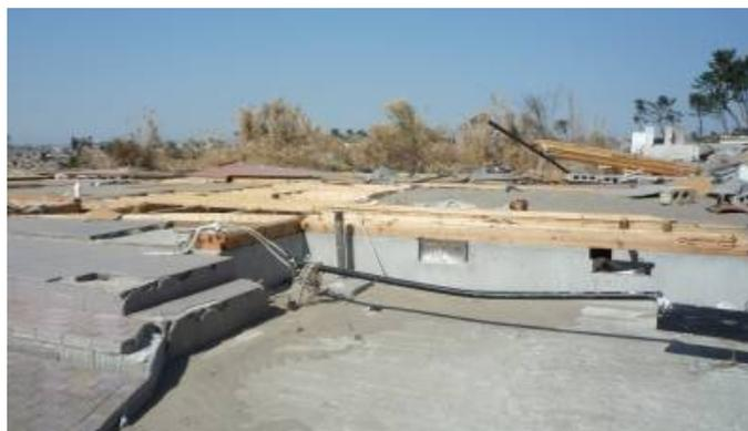
写真 6.4.3-1 上部構造が流失し土台が残った例
