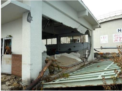
写真 6.3.10-46 センター内での非構造壁脱落
