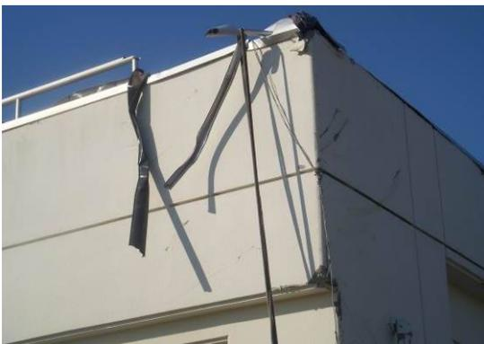
写真 6. 3. 10-13 写真 6. 3. 10-12 の 2 階手摺の破損
