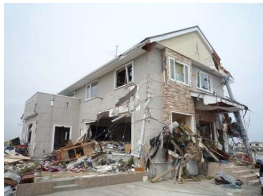
写真 6.3.11-13 単独で残存する枠組壁工法 (⑩) 住宅
