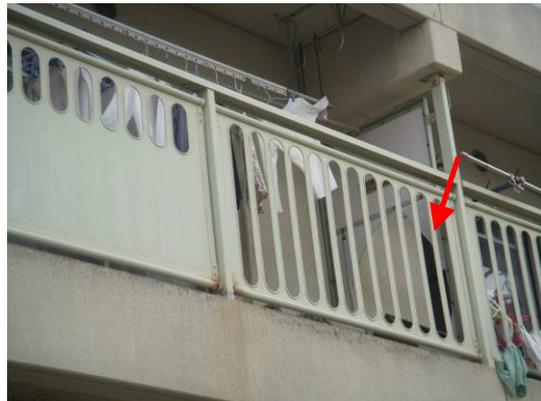
写真 6. 3. 11-32 住戸間の仕切りの破損状況
