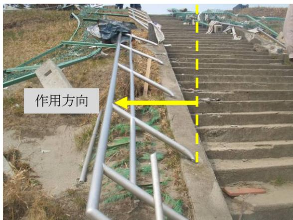
写真 6.2.1-2 手すりの津波による折損状況
