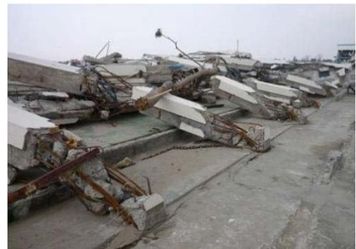
写真 6.2.1-1 2階建て建築物の倒壊
