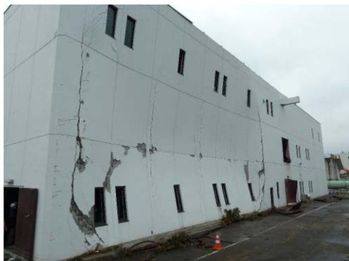
写真6.2.1-13 2、3階部分に床を持たない連層壁の面外破壊（建築物の奥の部分には2、3階部分に床がある）
