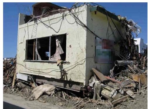
写真 6.2.1-2 2階建て建築物の層崩壊
