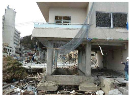
写真 6.2.1-9 洗掘による基礎の露出
