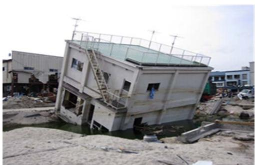
写真 6.2.1-10 洗掘による2階建て建築物の傾斜
