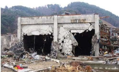
写真6.2.1-12 非構造壁の面外破壊
