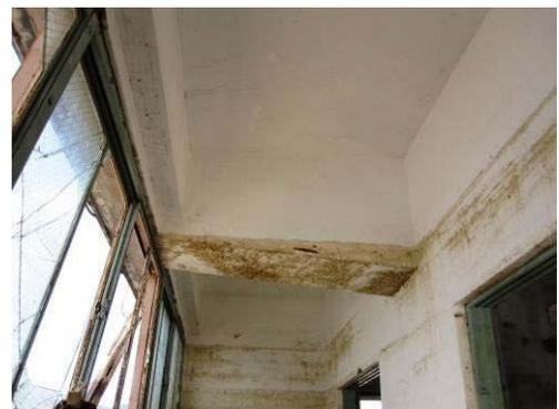
写真 6.2.1-6 建物内部の水の汚れの痕跡
