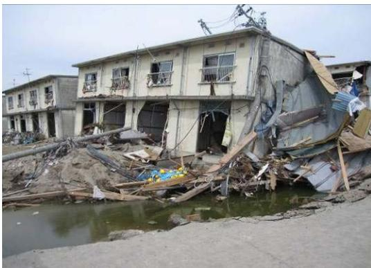
写真6.2.6-1 周辺地盤の洗掘による傾斜
