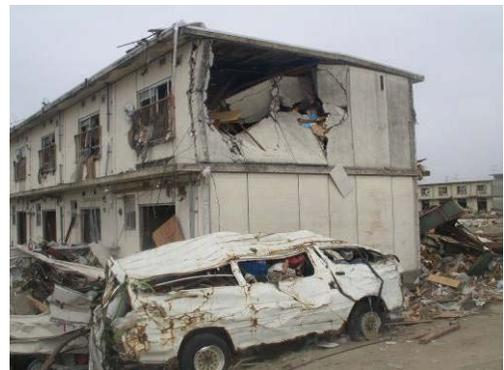
写真6.2.1-15 漂流物の衝突により生じた壁の開口
