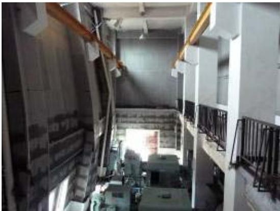
写真 6.2.5-3 建築物内部の浸水痕跡
