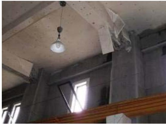
写真 6.2.5-2 屋上階梁下端の損傷
