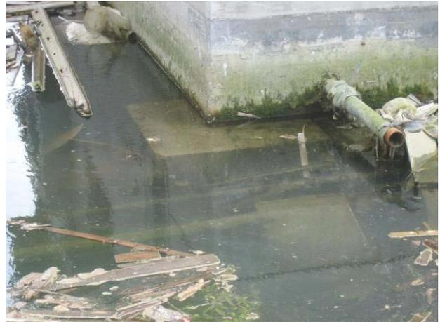
写真 6.2.7-2 洗掘により露頭したフーチング (写真 6.2.7-1 の棟の北東隅部)
