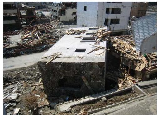
写真 6.2.1-5 4階建て杭基礎建築物の転倒
