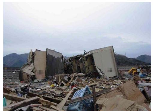
写真 6.2.1-8 CB造集合住宅の転倒
