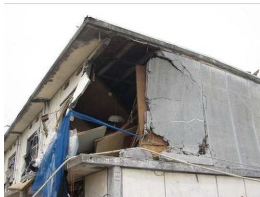
写真6.2.6-2 2階妻壁の損傷
