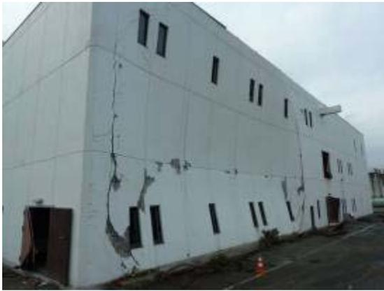
写真 6.2.5-1 耐震壁の面外変形
