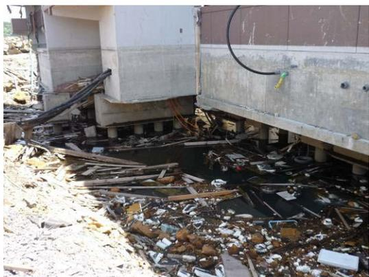
写真 6. 2. 2-5 基礎の洗掘 (中央部)
