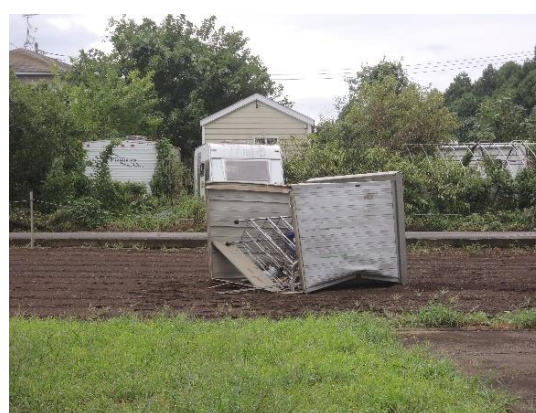
写真 3.8 鋼製物置の飛散状況
