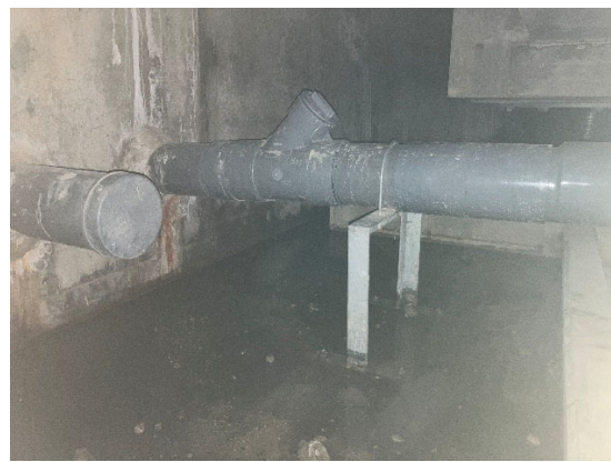
(a) 本館地下の免震層内の配管
