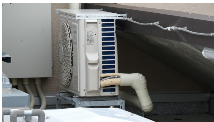
図 4.9.4 転倒した室外機（屋上）（頂部支持を追加して復旧済み）
