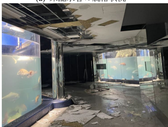
(c) 床配水管の漏水による天井落下状況
