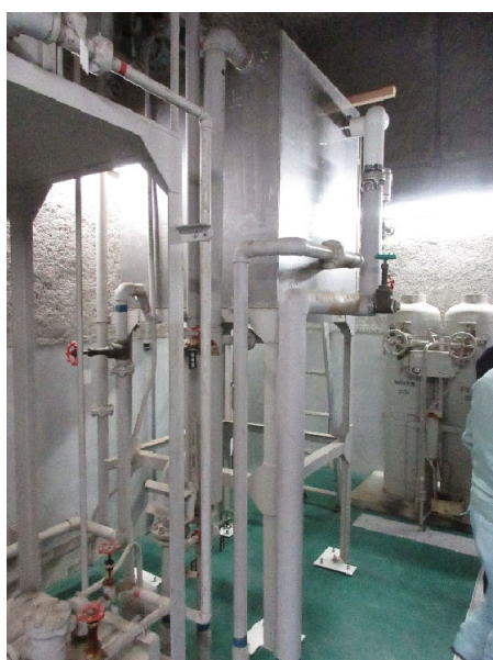
(a) 自家発電設備
