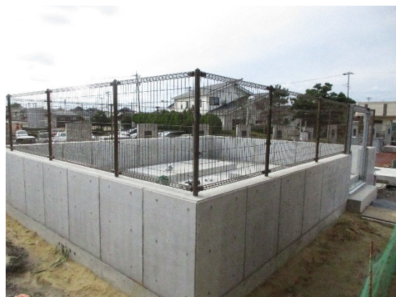
図 4.28.4 屋外に建設中の自家発電設備
