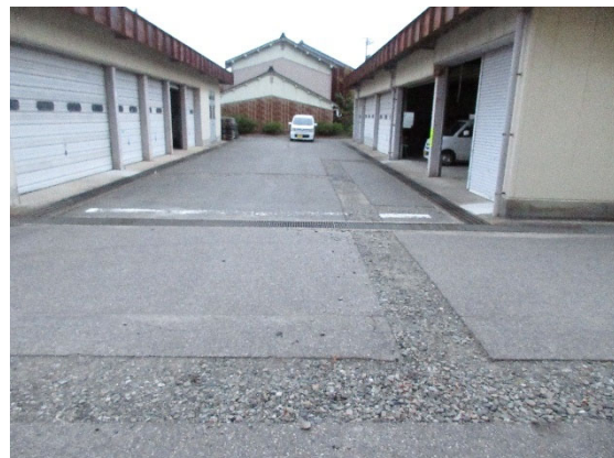
図 4.29.12 東側車庫周辺の配管補修
