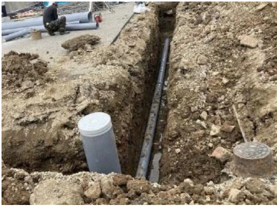
図 4.12.4 メイン排水管の復旧工事の状況
