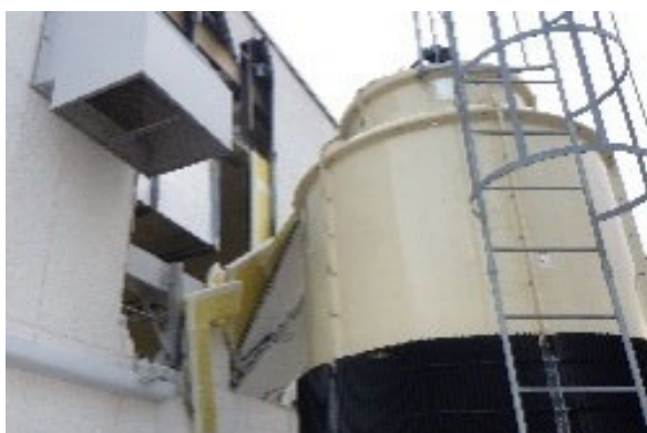
(a) 6F 冷却塔の上に落ちた外壁パネル
