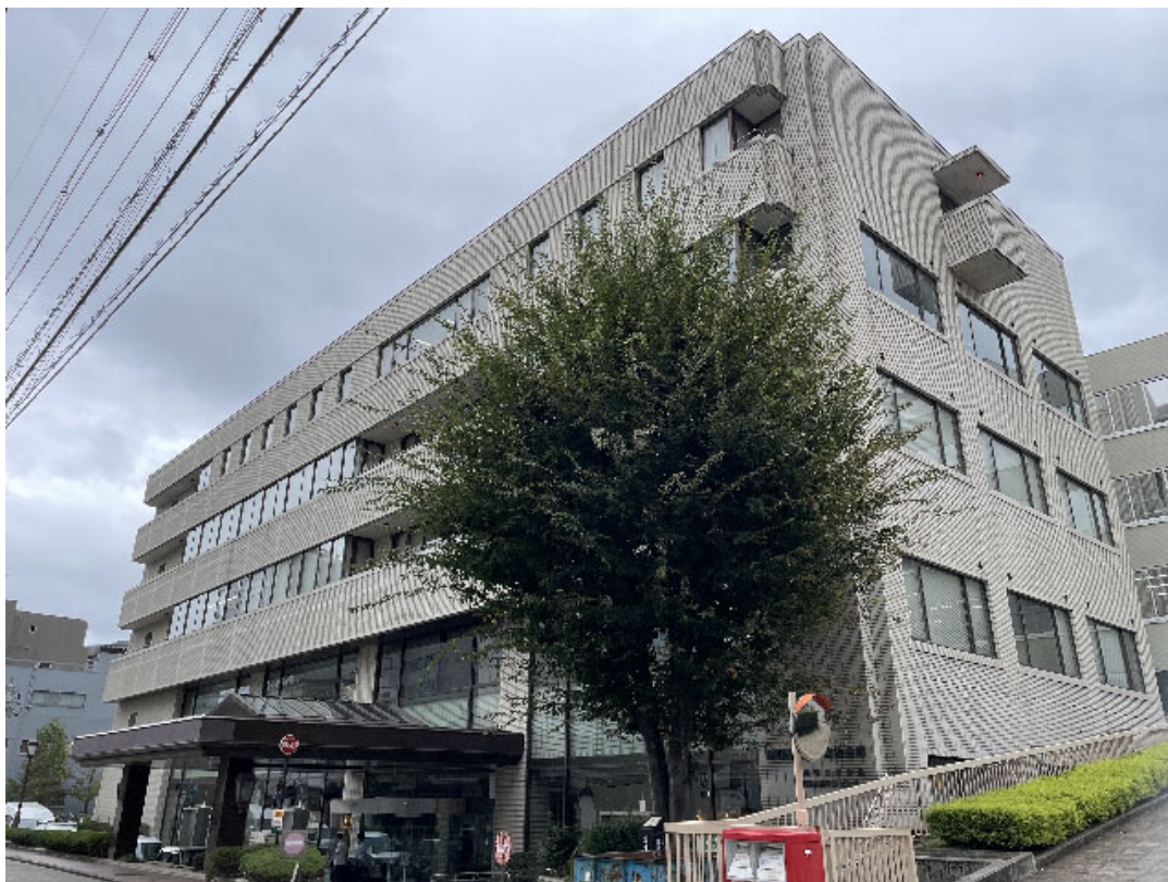
図 4.3.1 建築物外観（南西側）（建築物 C）
