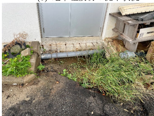
(d) 地中埋設配管の復旧状況
