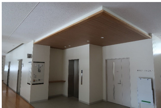
図 4.33.13 増設されたエレベータ
