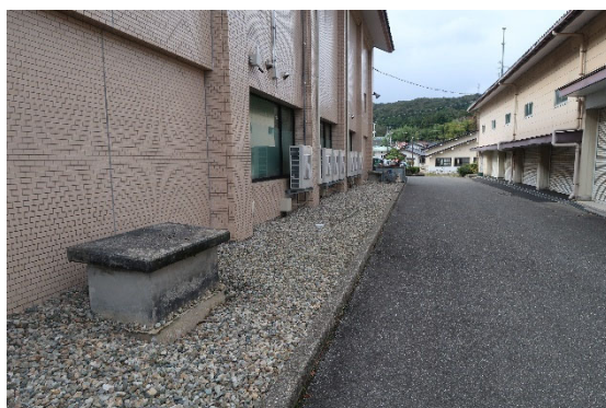
図 4.33.17 建築物 AG-1 北側の地盤変状
