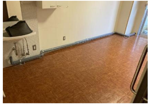
図 4.12.5 露出配管による排水の復旧状況
