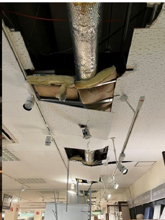
図 4.11.3 配管の脱落
