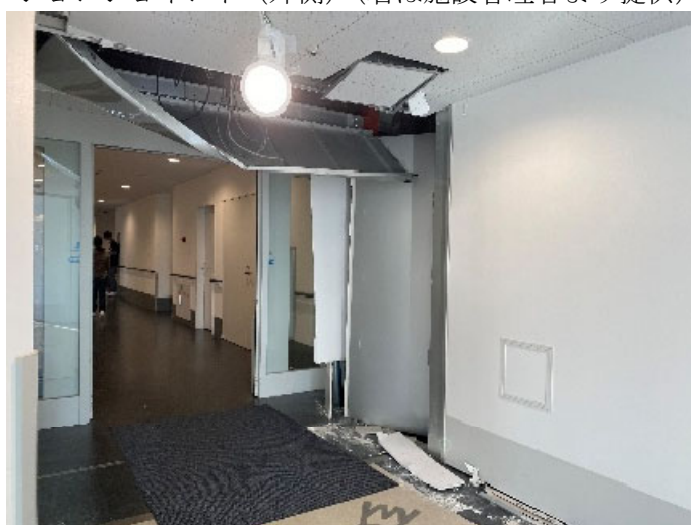
(b) 本館と3号棟の間のエキスパンションジョイント（内側）（施設管理者より提供）
