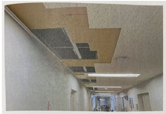
(b) 天井解体状況
