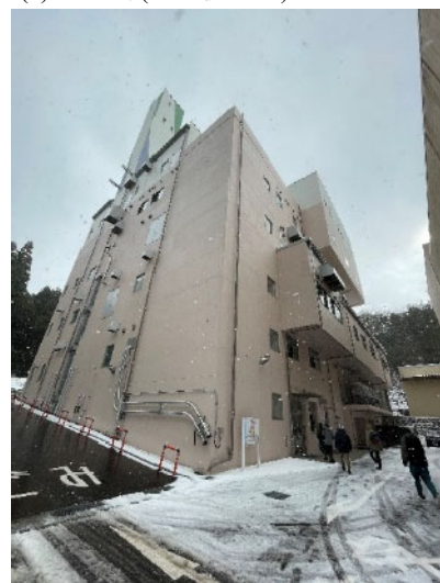
(e) クリーンセンター棟
