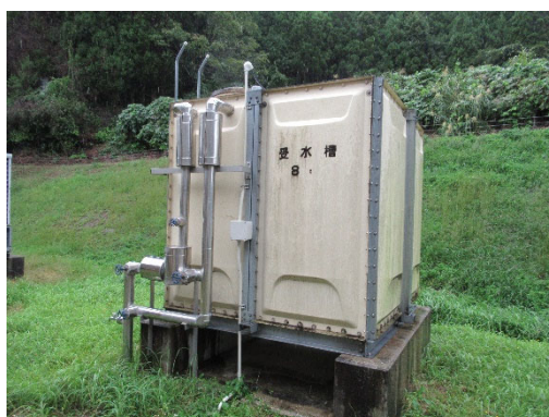
図 4.4.5 屋外受水タンク（建築物 D）
