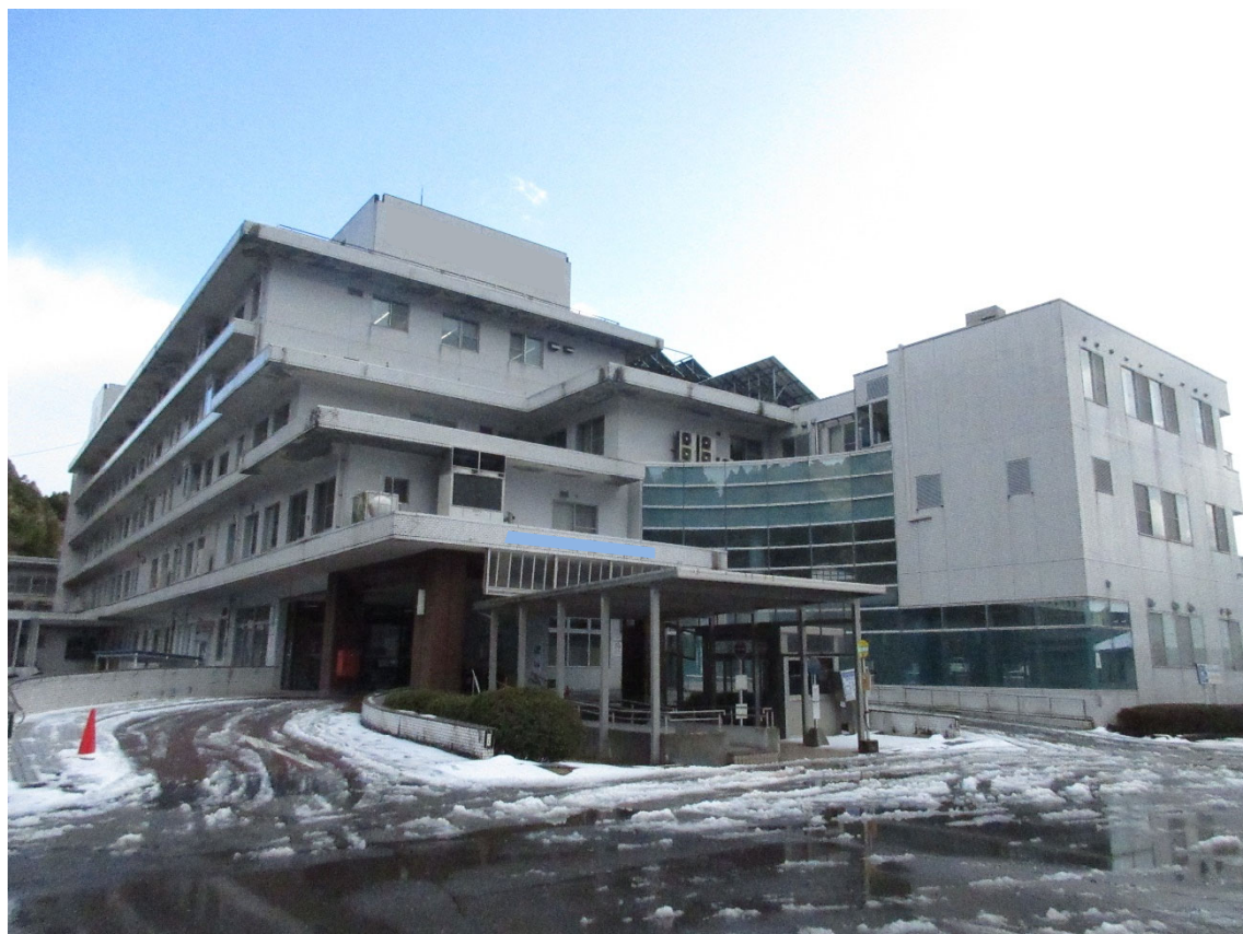
図 4.25.1 建築物外観（建築物 Y）
