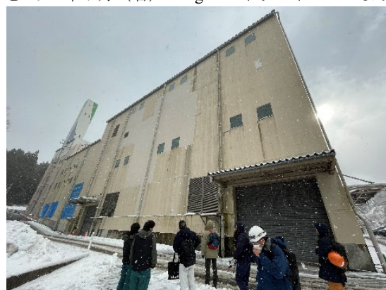
(c) RDF 棟(外壁復旧跡)
