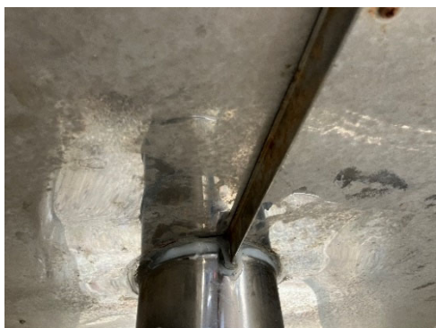
図 4.2.5 ボイラ用補給水タンクの修繕箇所
