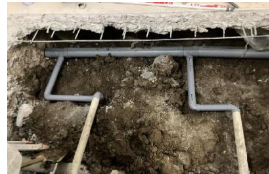
図 4.12.6 土間配管の破損状況（左）と復旧工事の状況（右）
