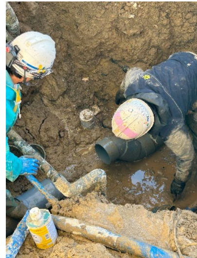
(b) 本館玄関前での埋設排水管の復旧工事状況（施設管理者より提供）
