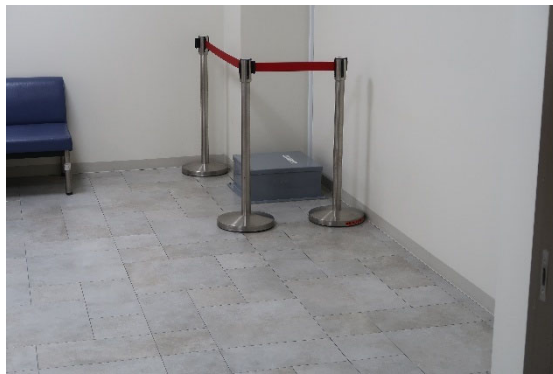
図 4.33.9 移設された震度計
