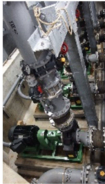
(g) 更新後のポンプ
