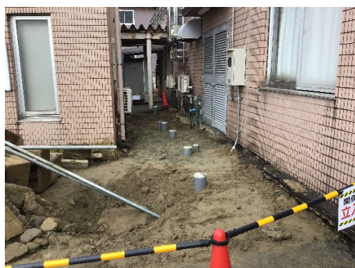
(a) 建築物周囲の排水管復旧状況
