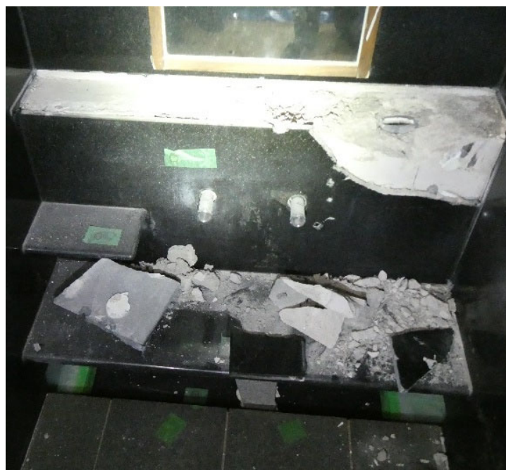
図 4.9.6 洗い場の埋設配管（給水・給湯）
