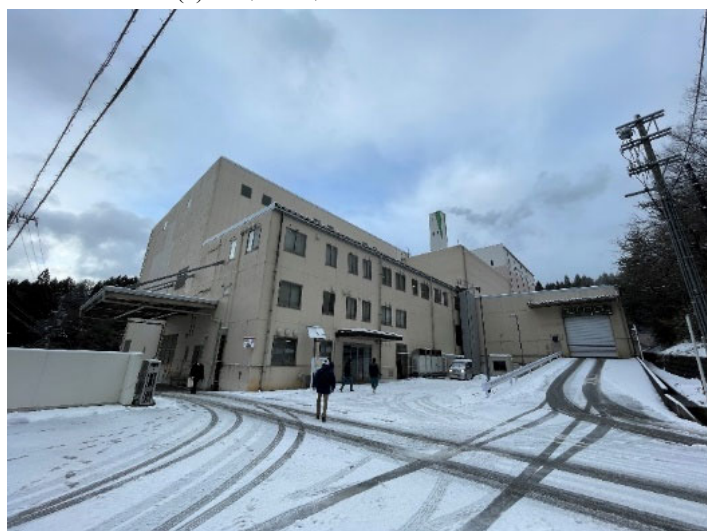
(d) 管理棟側から見た建築物全景
