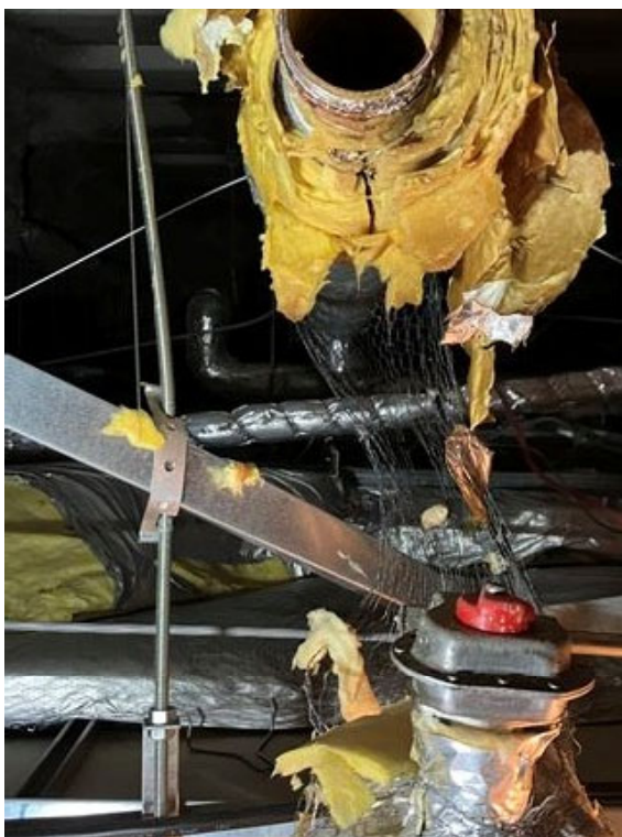
図 4.11.2 配管の破断
