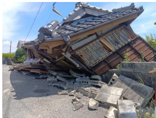
写真 7.2.4 木造住宅の倒壊
