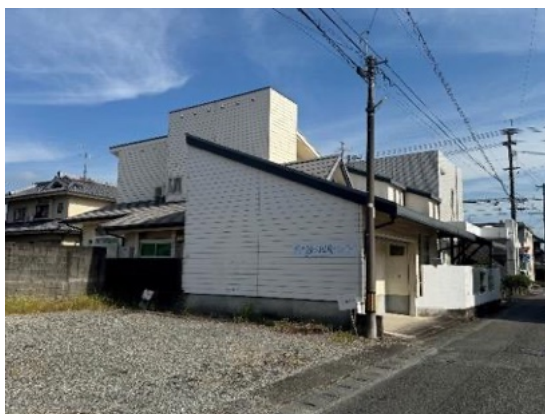
写真 8.2.12 住宅（外観被害なし）
