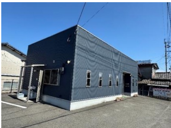
写真 6.2.4 写真 6.2.3 の建物に隣接する 外観上無被害と思われる建物
