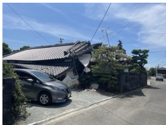
写真 7.2.6a 築年数 80 年以上の木造住宅 の倒壊
