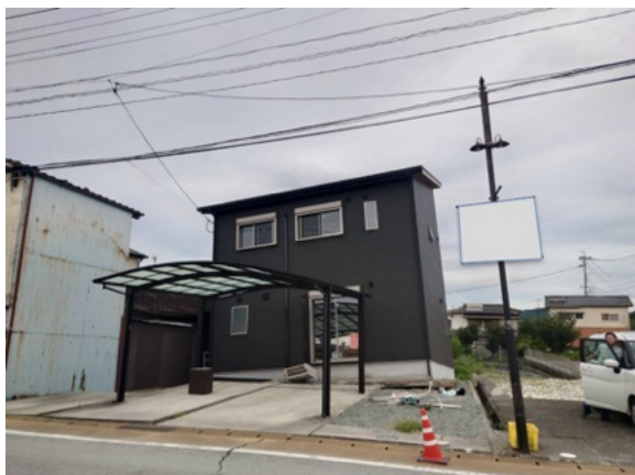
写真 A.1 地盤変状が確認された建物の外観 (国土技術政策総合研究所三木氏提供)
