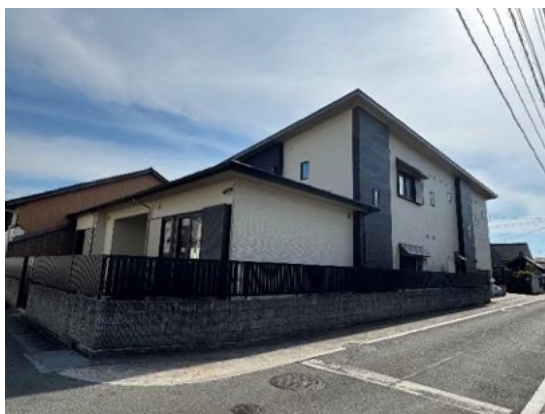
写真 8.2.14 住宅（外観被害なし）
