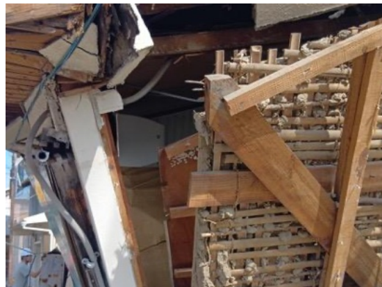
写真 8.2.2 土壁＋筋かい（端部は釘留め）
