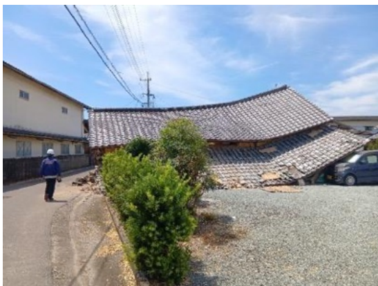
写真 7.2.3 木造住宅の倒壊
