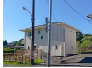
写真 5.2.8 外観上、無被害と 思われる住宅
