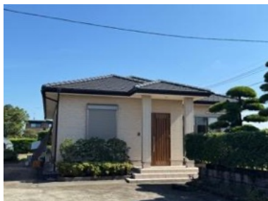
写真 5.2.10d 隣接する外観上 無被害と思われる住宅
