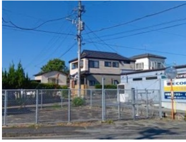
写真 5.2.6 外観上、無被害と 思われる住宅
