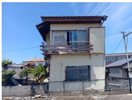
写真 6.2.11 残留変形
