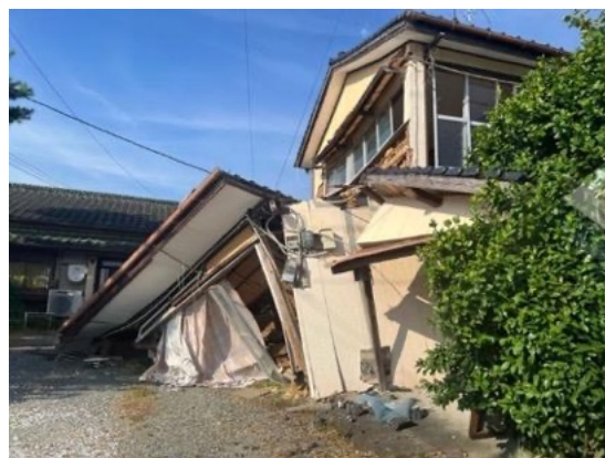
写真 7.2.2 木造住宅の倒壊
