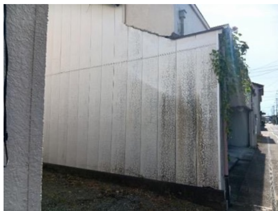
写真 8.2.10 外壁のずれ
