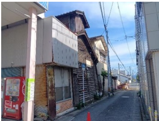
写真 8.2.3 住宅の傾斜
