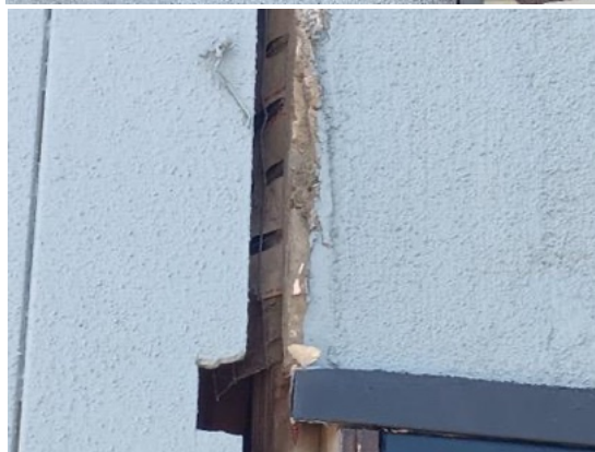
写真 6.2.12 外壁の損傷
