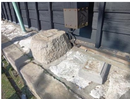
写真 8.2.18 礎石からのずれ（50cm 程）
