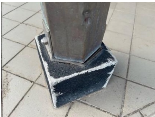
写真 9.2.1c 柱のずれ
