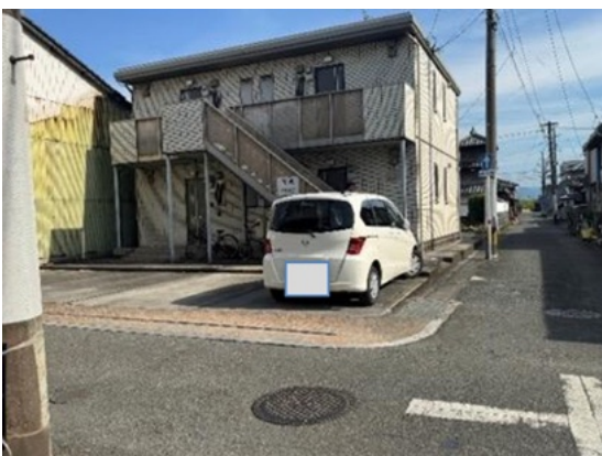
写真 8.2.13 アパート（外観被害なし）
