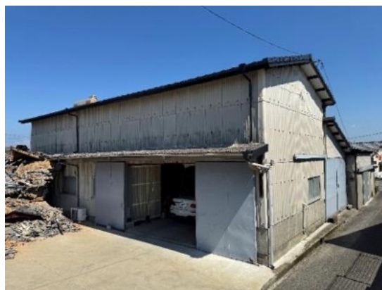
写真 6.2.2 写真 6.2.1 の建物に隣接する建物
