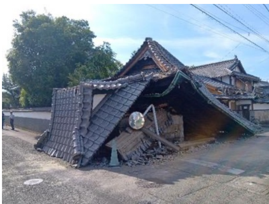
写真 8.2.15 社寺建物の倒壊
