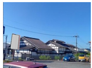
写真 5.2.5b 隣接する建物の瓦屋根被害
