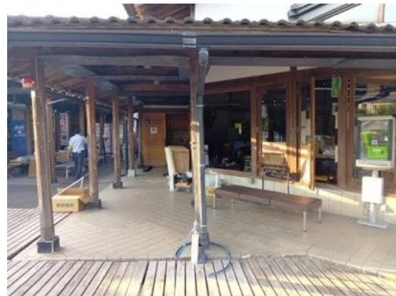
写真 9.2.1b 中規模木造建築物柱の傾斜 1/18\text{rad}
