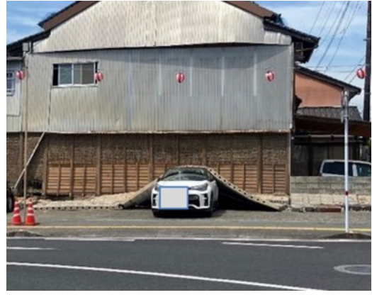
写真 7.2.14 外壁の脱落
