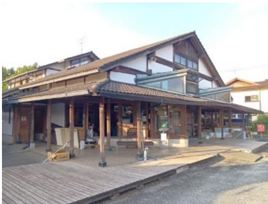
写真 9.2.1a 中規模木造建築物の概観
