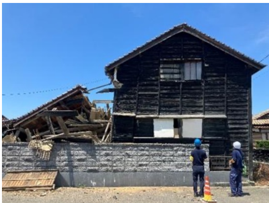
写真 6.2.10 残留変形 81/1000=1/12\text{rad}
