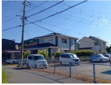
写真 5.2.7 外観上、無被害と 思われる住宅
