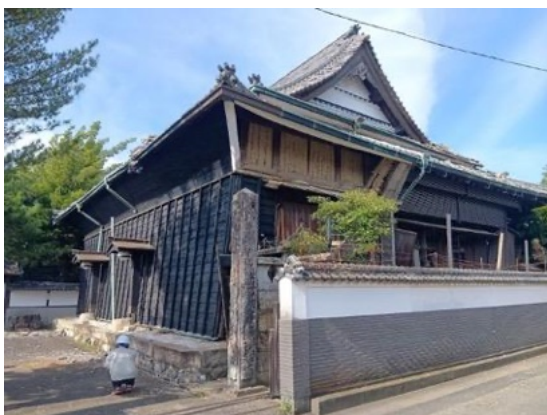
写真 8.2.17 社寺建物の傾斜
