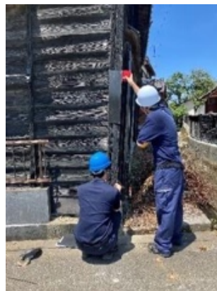
写真 6.2.10 残留変形 81/1000=1/12\text{rad}
