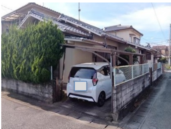
写真 8.2.11 築 40 年程の住宅（外観被害なし）
