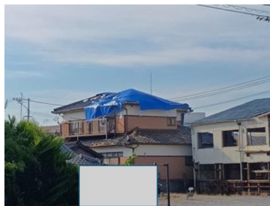
写真 8.2.24 瓦の脱落
