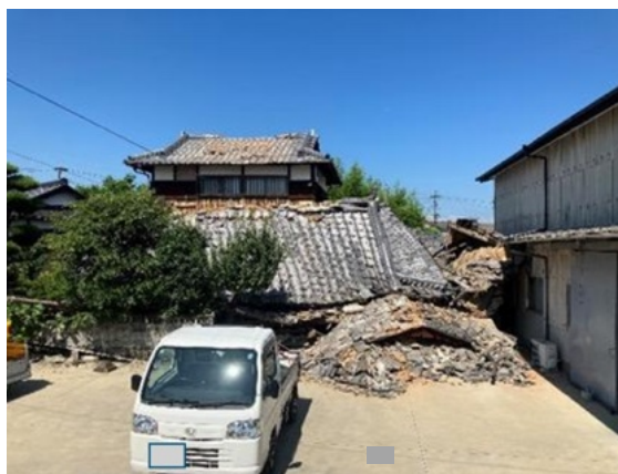
写真 6.2.1 氷川町鹿島の倒壊家屋
