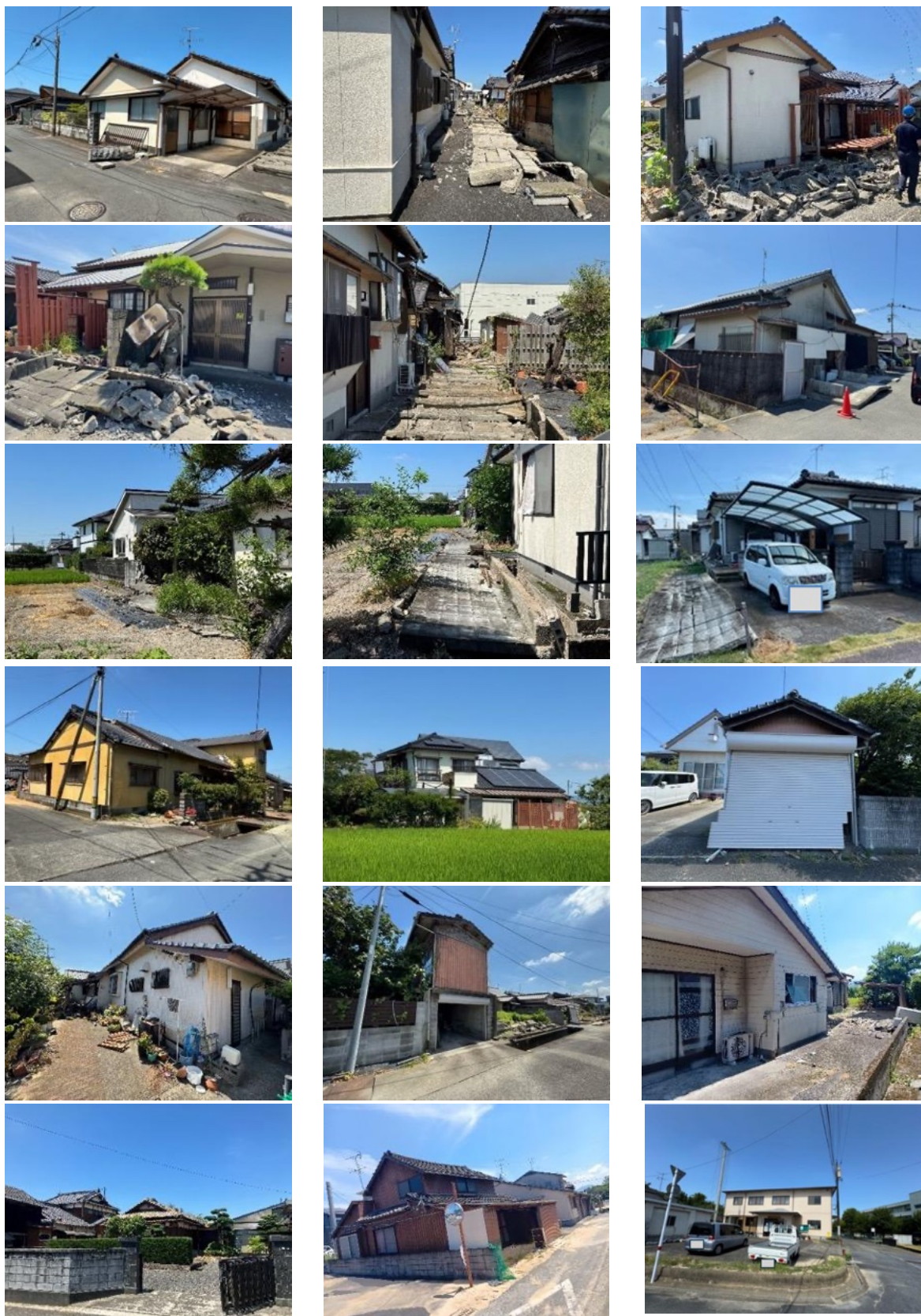
写真 6.2.13 古いが被害の程度が小さい住宅（コンクリートブロック塀の倒壊等あり）
