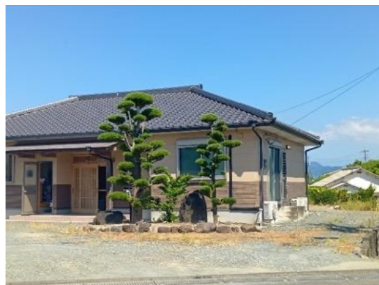
写真 6.2.5 外観上無被害と思われる建物
