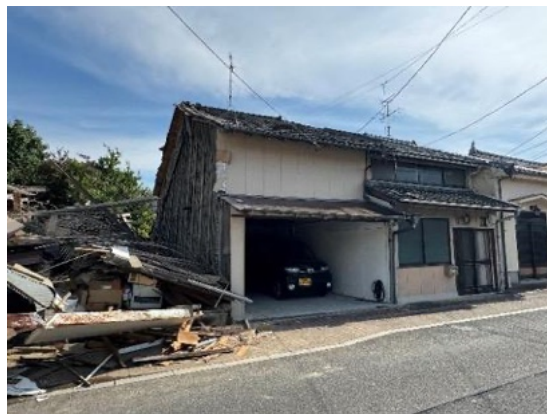
写真 8.2.6 同年代の隣接住宅（倒壊なし）
