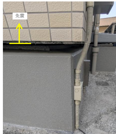
図 4.3.1-2 周囲の配管の状況
