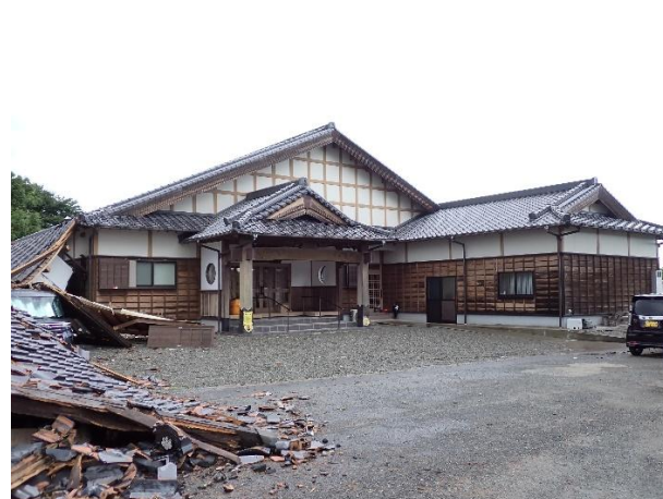
写真 2.4.10 倒壊した寺社 C に隣接する建築物の外観
