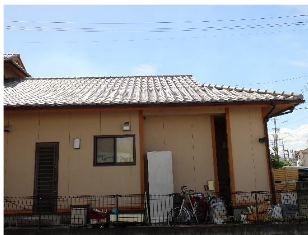
写真 2.2.4 屋根の状況 (住宅 C)
