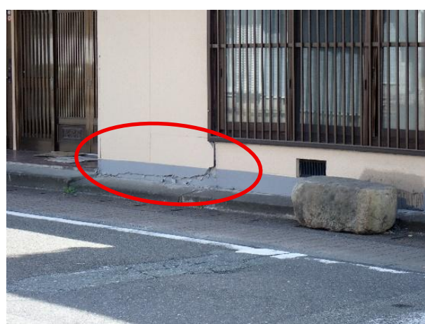
写真 2.2.6 基礎の状況 (住宅 D)
