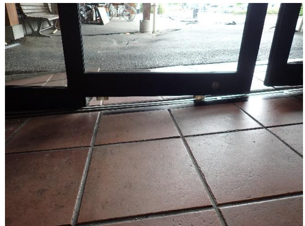
写真 2.1.4 床の傾斜
