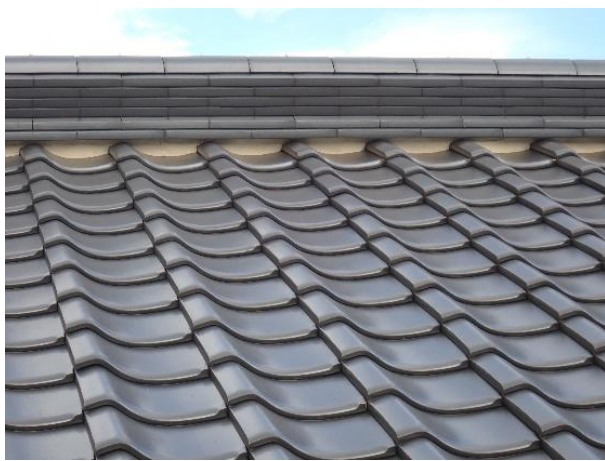
写真 2.3.2 屋根の平部と棟部の状況（住宅 E）
