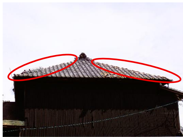
写真 2.2.7 隅棟部の瓦の脱落
