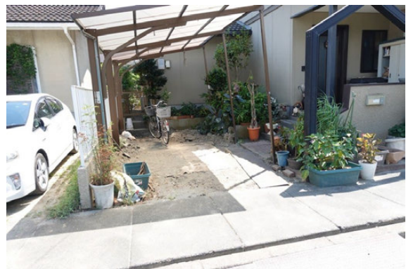
写真 5.2 図 3.2 の地域 A の住宅、液状化によるものと思われる噴砂
