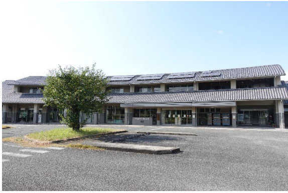
写真 4.19 宇城市豊野町の公共建築物、傾斜なし
