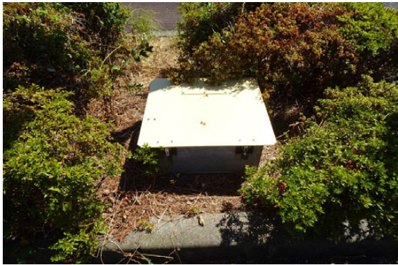
写真 4.21 宇城市不知火町の強震観測点（震度計）
