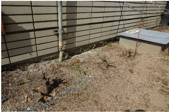
写真 4.15 氷川町島地の強震観測点周囲の地盤変状
