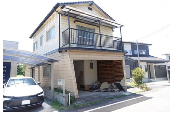
写真 5.4 図 3.4 の地域 B の住宅、1 階が大きく変形している
