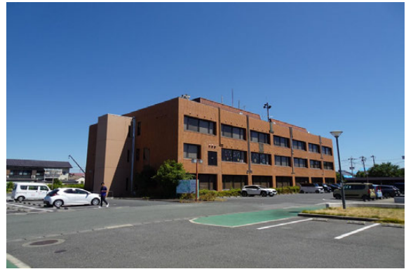
写真 4.22 宇城市不知火町の公共建築物、傾斜なし
