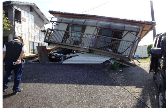
写真 4.20 宇城市豊野町の強震観測点付近の住宅は1階の崩壊が確認された
