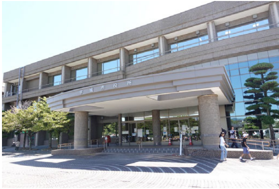
写真 4.25 宇城市松橋町の公共建築物、傾斜なし
