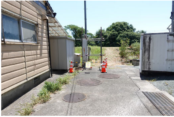
写真 5.3 図 3.4 の地域 B の様子と地下水位低下工法に関係するとみられる装置
