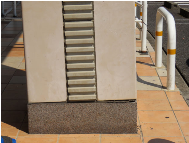
写真 YA-03-c 柱の外装材の傾き
