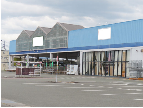
写真 UT-01-a 建物外観
