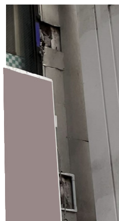
写真 KU-05-b 脱落した看板の取り付け元
