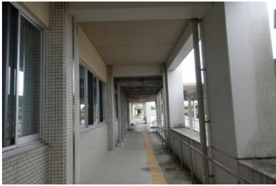
写真 3.4.2-7 外周フレームとの接続部分（無損傷）
