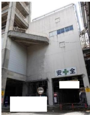
写真 3.2.3-5 建築物 Y-6 の外観
