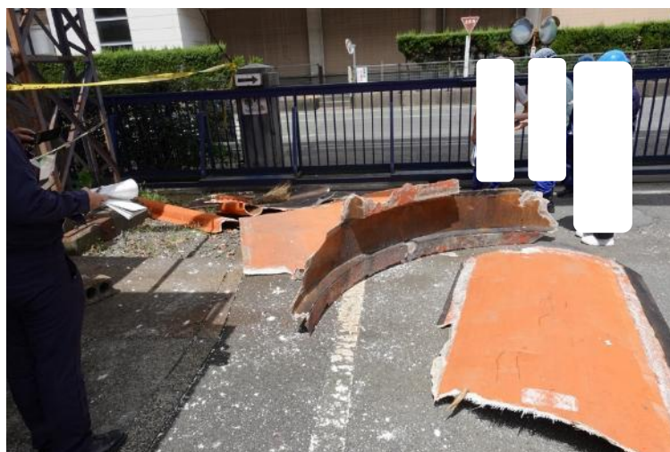
(d) 地上に落下した破片の一部
