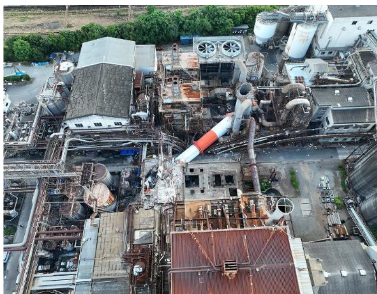
(a) 転倒した煙突周辺の状態
