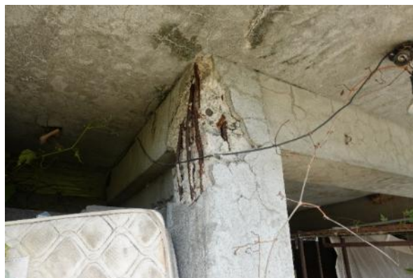
写真 3.4.14-2 柱頭の被害
