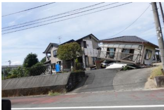
写真 3.4.3-3 庁舎周辺の戸建住宅の倒壊
