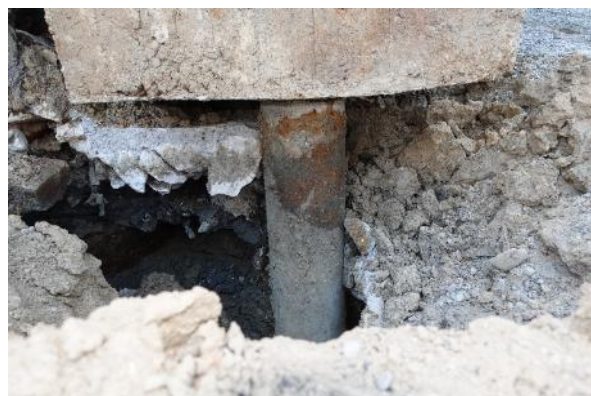
写真 3.4.12-2 杭頭の露出
