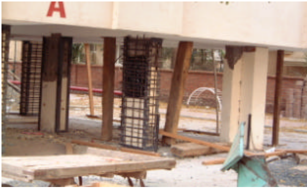
写真5 ピロティ部分の応急補強
