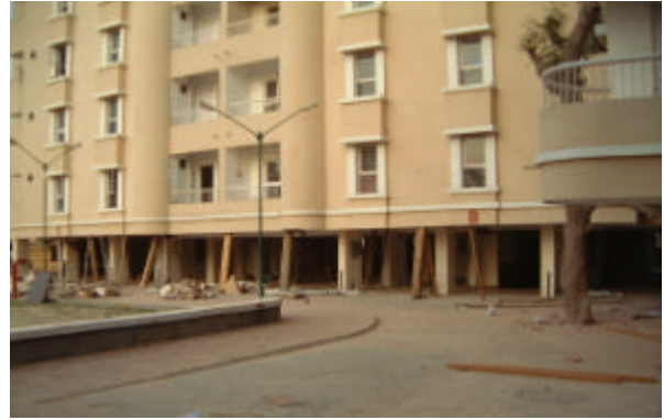
写真6 木材による軸力保持（応急措置）
