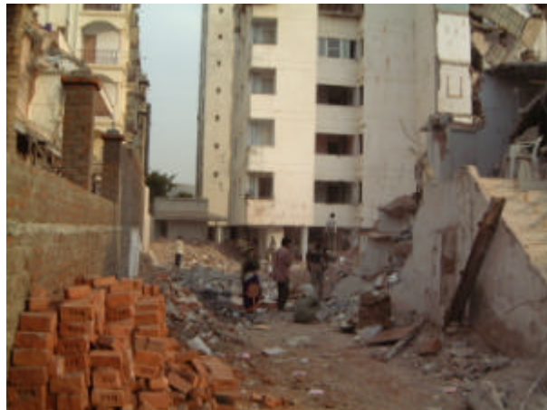
写真 2 ピロティ部分
