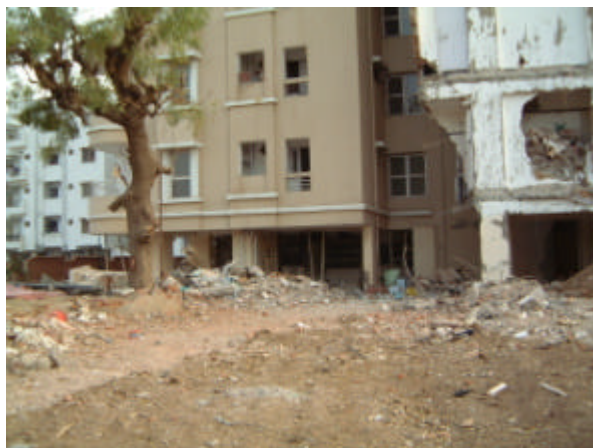
写真 4 ピロティ部分
