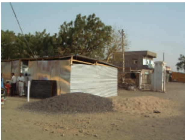
写真 1 4 Anjar での学校仮設施設(職員室、物置) 木造で構造体をつくり、トタン板で屋根と 壁を作っている。床は土間。
