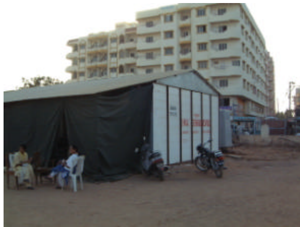
写真 1 3 Bhuj 総合病院(倒壊)の仮設施設 (妻面 6 m、天井高 3 m、天井・天井裏あり、床は 30cm × 30cm のコンクリート平板敷詰め)
