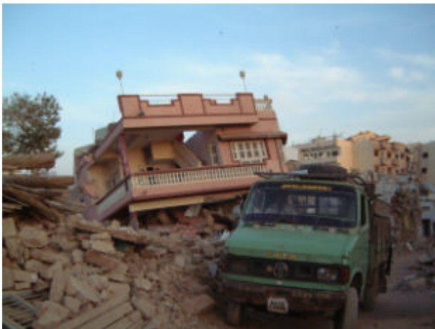
写真9 Bhuj 旧市街地での被害 （組積造の崩壊）
