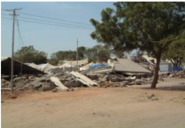
写真7 Bhachau での被害 （低層住宅がほぼ全壊していた。）
