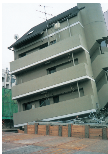
1995年の兵庫県南部地震で大きな被害を受けた建物。1階が完全に潰れている
