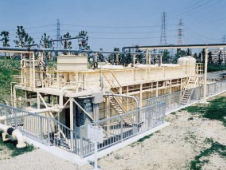
21. バイオテクノロジーを活用した新排水処理システムの開発 滞留時間、反応槽容量をそれぞれ従来の1/2にした包括固定化窒素除去プロセス（下水道事業団大阪北東エースセンター） Development of new wastewater treatment systems employing biotechnology The comprehensive nitrogen fixing and removal process at Osaka's Hokuto Ace Center, run by the Japan Sewage Works Agency, halves previous retention times and reactor volumes.
