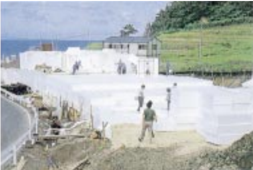
27. 建設事業への新素材・新材料利用技術の開発 発泡スチロールブロックを盛土の材料に利用したEPS工法 Development of new materials utilization technology in the construction industry The EPS process uses styrofoam blocks to build embankments.
