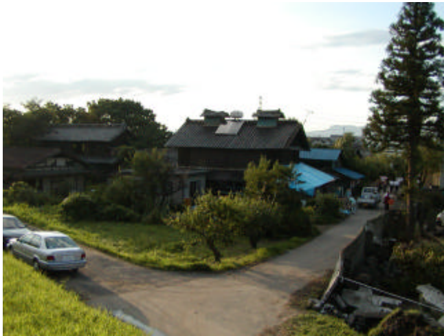
写真 21 天人寺西側の住宅(南からみる) 一部屋根が損傷しているが、建築物の倒壊/崩壊には至っていない。
