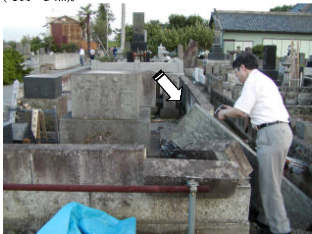
写真10 墓石の転倒(北からみる)
