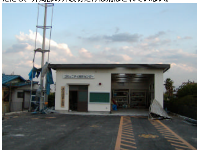
写真 18 消防センター外観(北からみる) 開口部のシャッターの破損。
