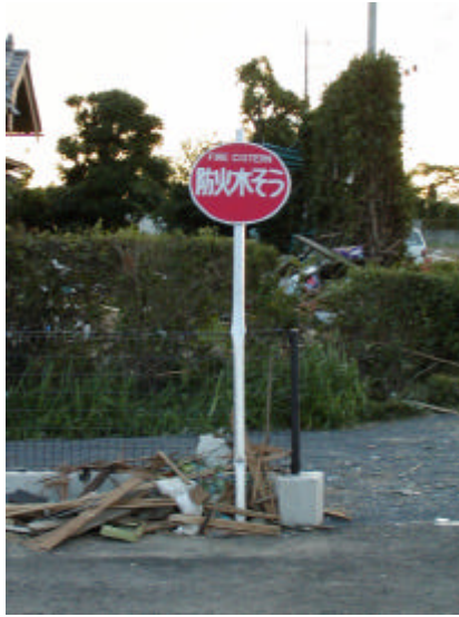
写真 19 標識の折れ曲がり(東からみる)
