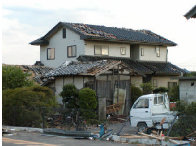
写真 16 住宅 C 外観(東からみる) 東西両方向からの屋根面外装材の剥離及び飛散がみられる。 ただし、外周部の外装材だけは飛ばされていない。
