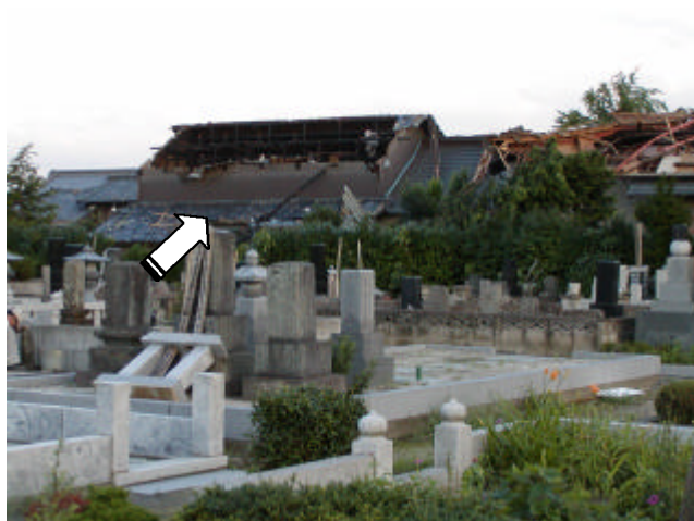
写真8 天人寺外觀(北からみる) 北側屋根面の外装材の飛散。南側屋根面には瓦が残っている (写真1参照)。
