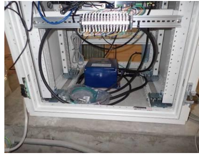
地震観測装置 SMAC-MDU(2)及びセンサー JEP-4A3W 設置状況
