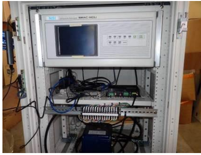
地震観測装置 SMAC-MDU(2)及びセンサー JEP-4A3W 設置状況
