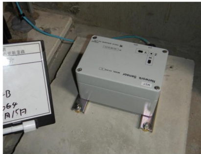
ネットワークセンサ CV-374 及び周辺機器設置状況
