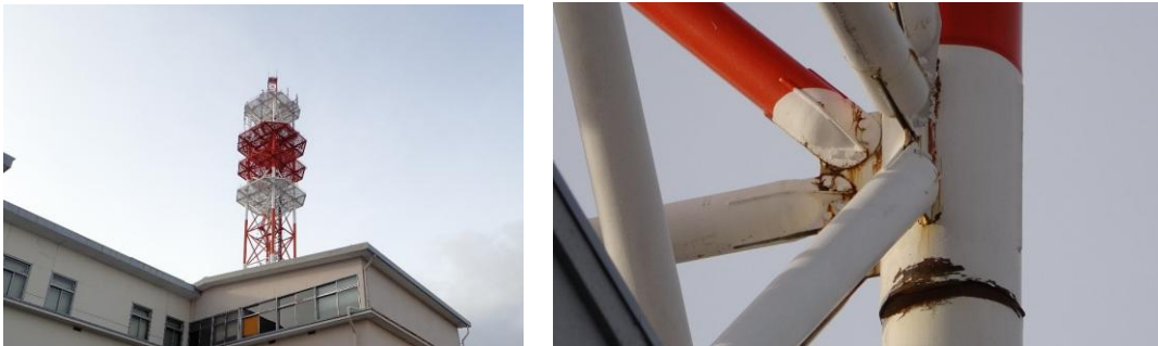
写真一 I-1. 2. ■ / 写真一 I-1. 2. ■ NTT 青森八戸ビル鉄塔復旧に係る技術的支援
