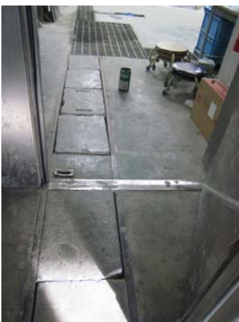
排水溝 (コンクリート蓋)
