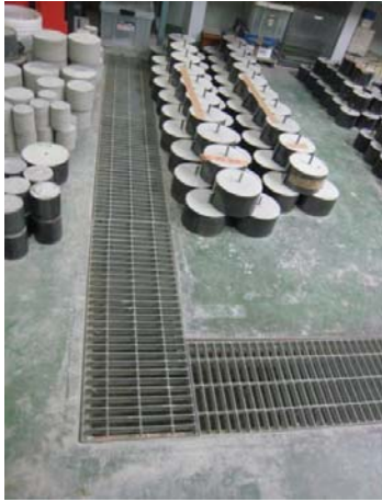
排水溝(グレーチング蓋)
