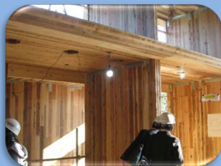
-CLT木造試験棟-
