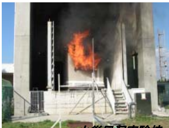
火災風洞実験棟
