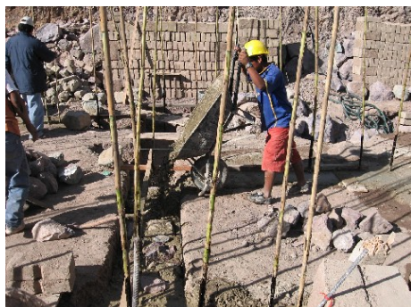
写真6 基礎のコンクリート打設 基礎は幅 55cm 高さ 80cm の無筋コンクリート。 縦の部材は、縦補強のカーニャ。
