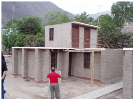
写真4 竣工後の耐震性アドベ住宅 控え壁が多く設けられている。 湿気防止のための基礎立ち上がり（赤色部分） は無筋コンクリートで高さ 30cm。
