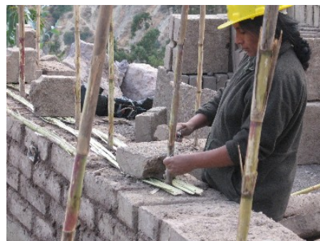
写真7 横補強のためのクラッシュしたカーニャの 設置作業。アドベ4層ごとに設置。縦のカーニャに ナイロン糸で緊結される。
