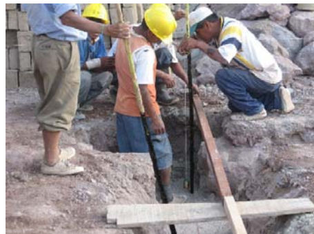
写真5 縦補強のためのカーニャの位置決め作業 捨てコン（10cm厚）に通心を出し、そこに80cm 毎に、縦補強のカーニャの固定のための釘を打つ。
