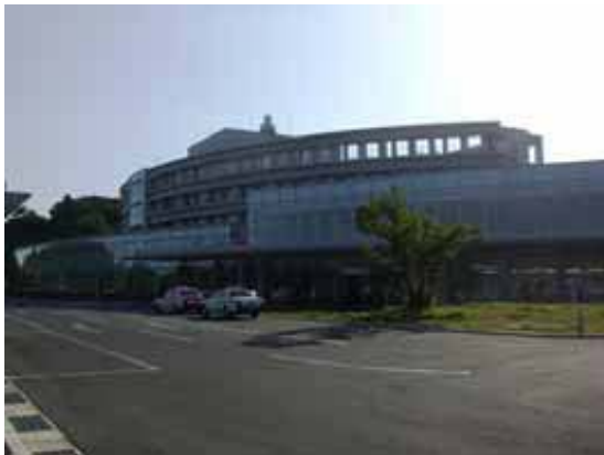
写真1 観測した免震建築物の外観
