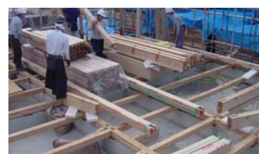
点検交換可能な床下空間
