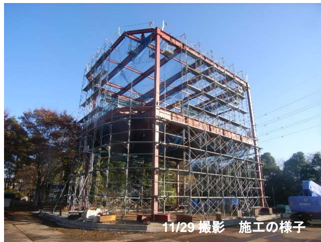
図2 建築研究所内（右写真）に建設中の長辺 22.5m×短辺 17.6m、高さ 15.5m の鋼構造躯体（左図）。この建物の施工検査において開発したシステムの実用性を検証する。
