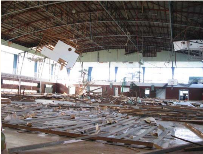
写真5.3-5 天井(木下地)、照明の落下
