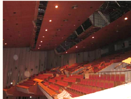
段差部・折り曲がり部
