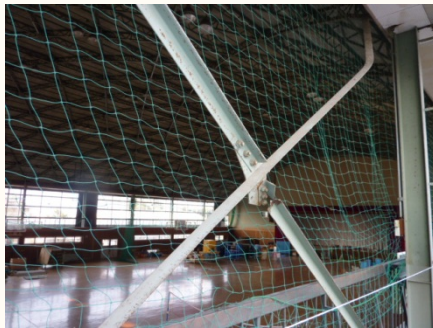
写真5.3-1 ブレース材の座屈と接合部破断
