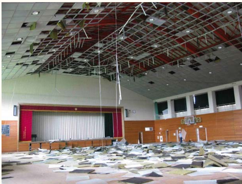
写真5.3-13 天井(システム)の落下
