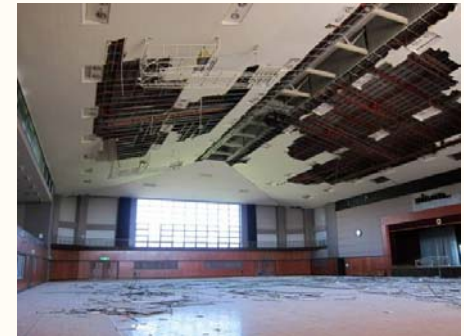
山形架構の屋根面に平行な天井
