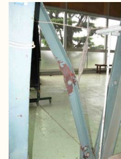
写真5.3-3 ラチス柱斜材の座屈
