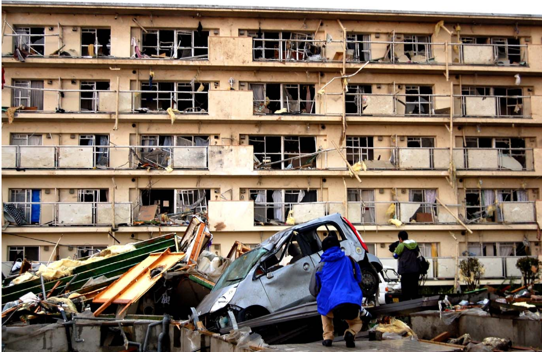
5階建て集合住宅の南側の窓ガラス、サッシの枠、ベランダの手すり等が損壊した。9
