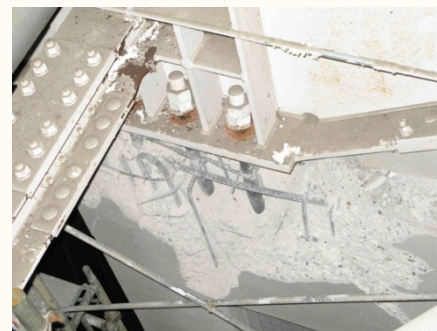
写真5.3-10 妻壁とS造屋根接続部のコンクリート破壊等
