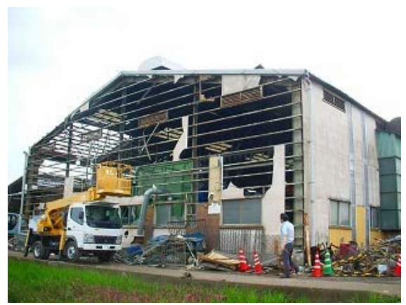
突風による外装材のはく離
