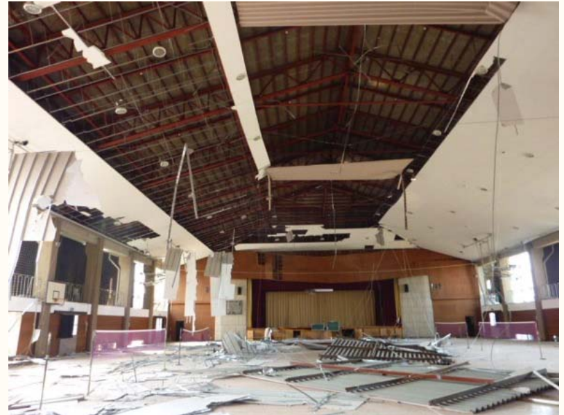
写真5.3-6 天井(在来工法)の落下
