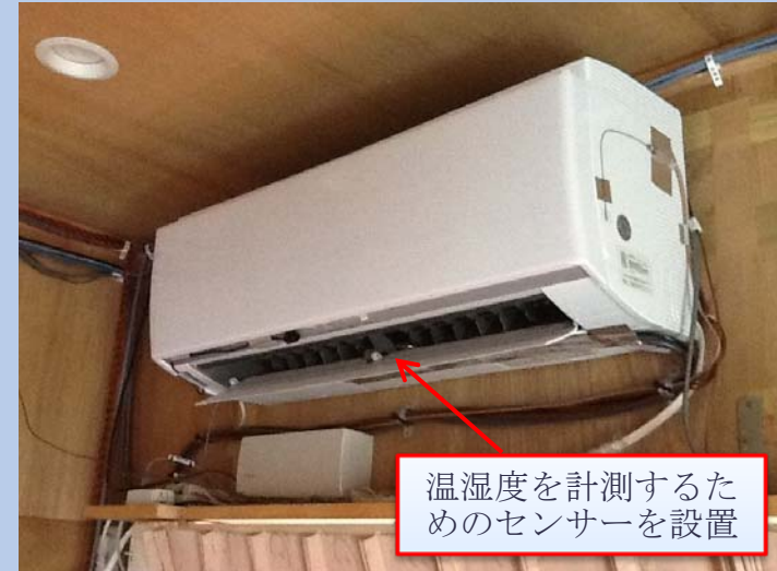
図2 実測対象エアコン
