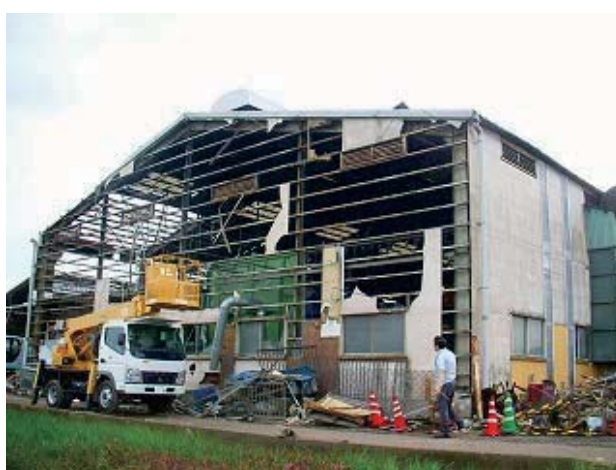
突風による外装材のはく離
