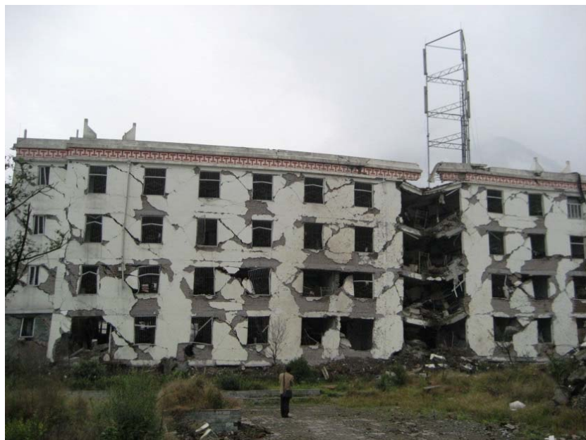
1階が崩壊した学生寮(四川省映秀)
