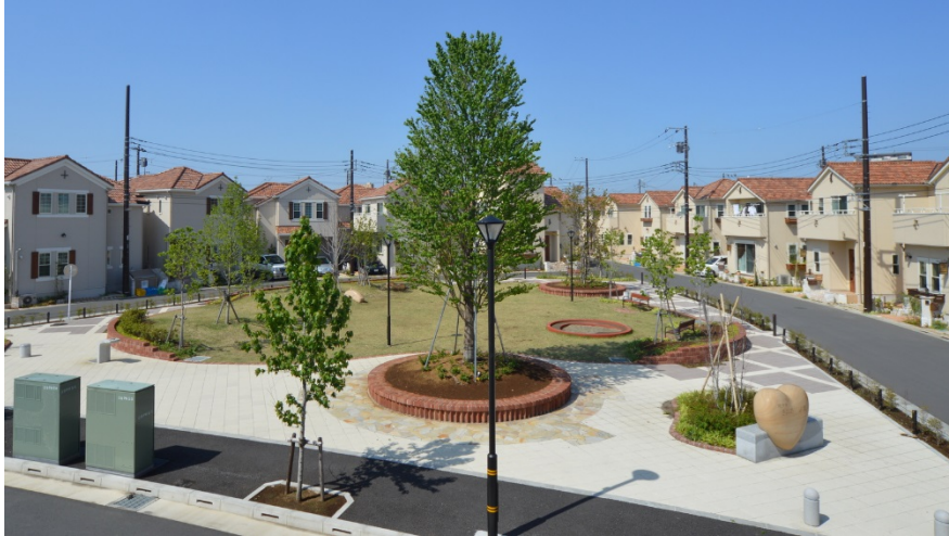
自然監視性の高い公園
