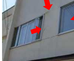
モルタル外壁の破損と下地の腐朽
