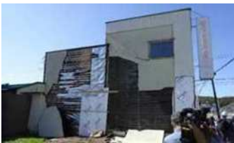
モルタル外壁の破損と下地の腐朽
