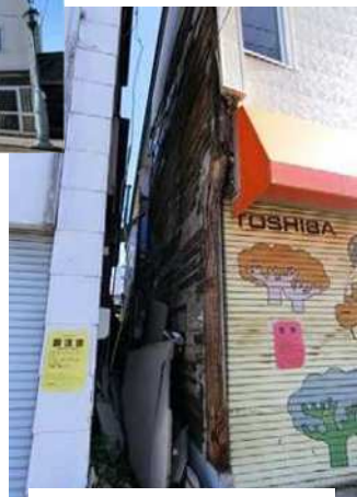
残留変形があり、外壁下地も腐朽
