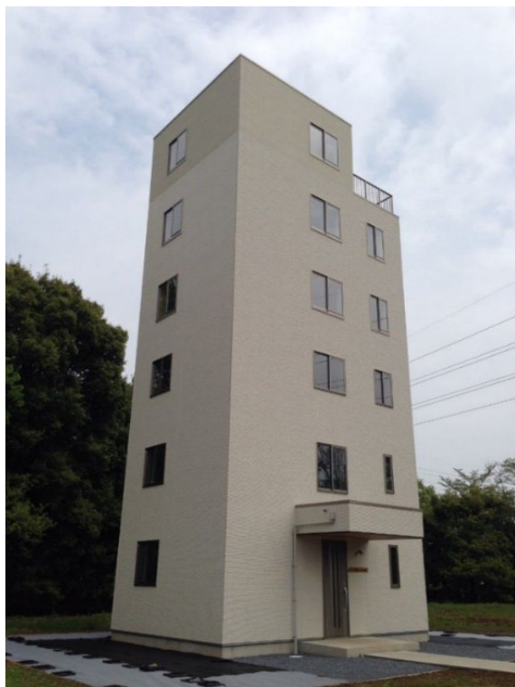
写真1 ツーバイフォー6階建て実大実験棟
