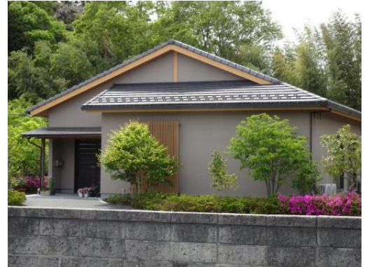
写真2-2 ガイドライン工法で施工されたと確認できた住宅
