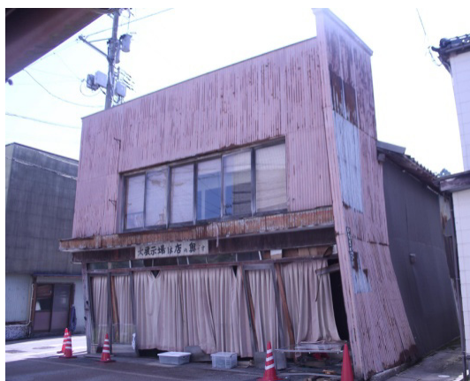
写真1-2 店舗併用住宅の傾斜
