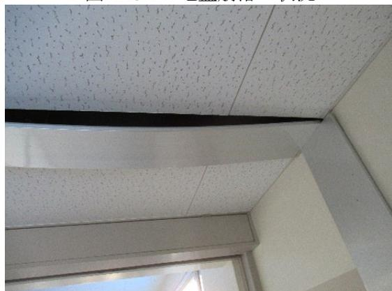
図 4.13.3 Exp. J. の損傷
