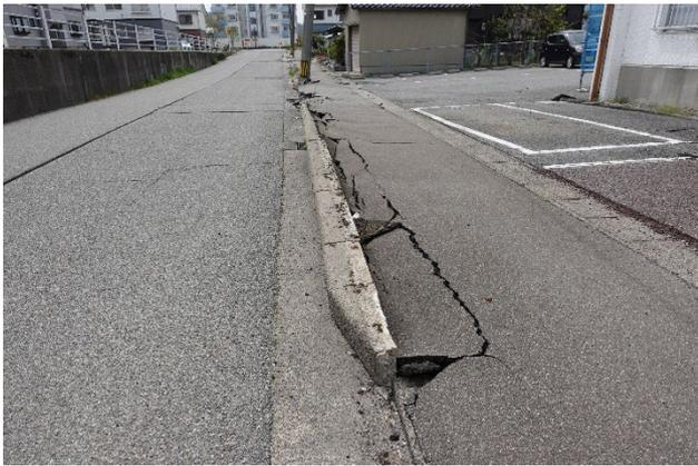
図 4.5.5 建築物 E-1 東側の地盤変状
