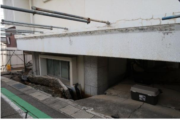
図 4.2.4 X4 構面 1 階部分の沈下
