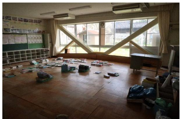
図 4.4.9 建築物 D-1 内部 1階床の膨れ上がり
