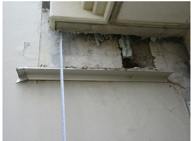
図 4.4.13 建築物 D-2 と別棟の Exp. J.の段差
