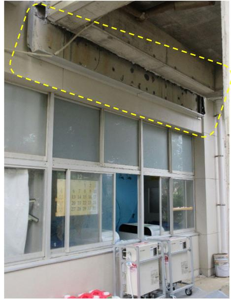
図 4.4.17 建築物 D-4 と別棟の Exp. J.のずれ
