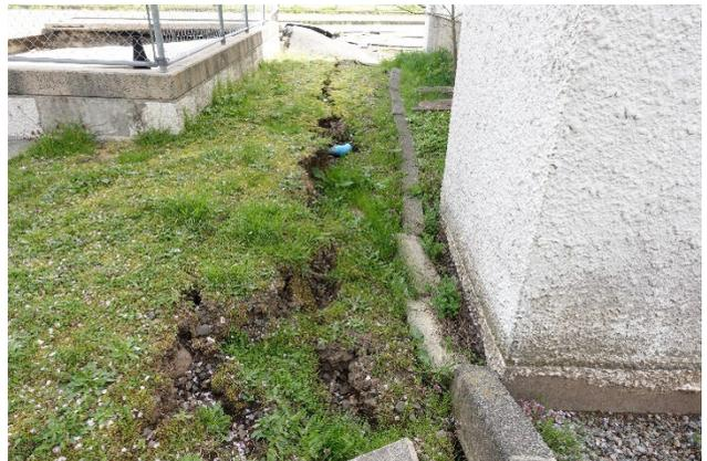
図 4.5.9 建築物 E-3 北側の地盤変状
