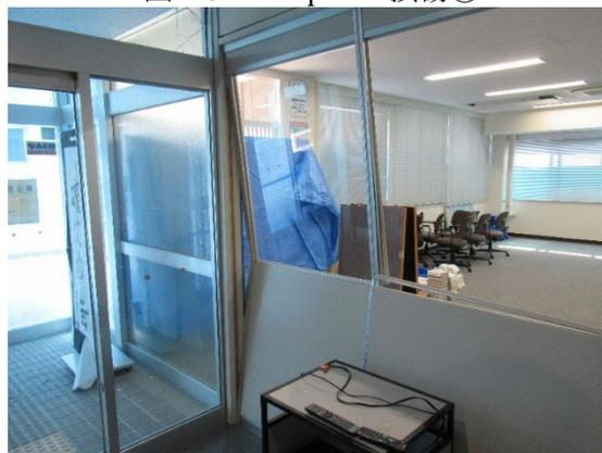
図 4.8.4 間仕切りの損傷
