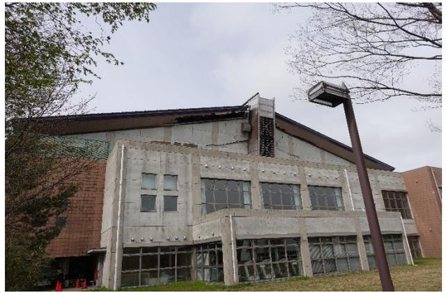
図 5.2.14 妻構面の RC 造壁の面外破壊②
