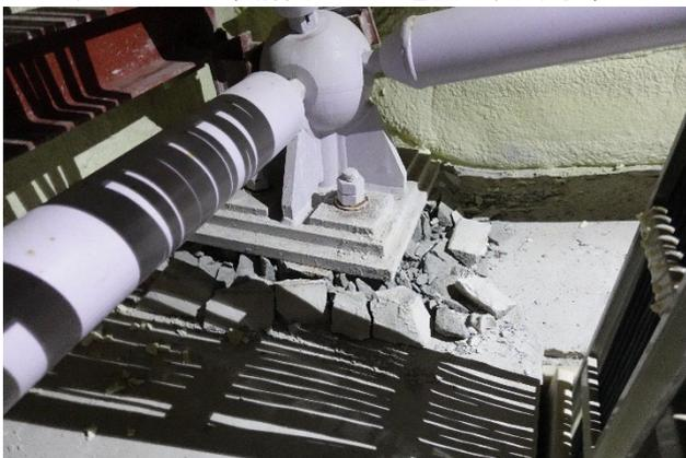
図 5.2.17 屋根支承部のモルタルの損傷
