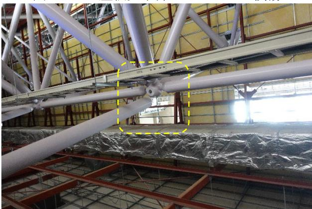
図 5.2.19 システムトラス屋根のポールジョイント部での破断
