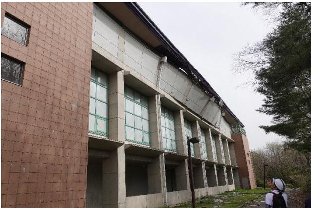
図 5.2.15 平構面の RC 造壁の面外破壊
