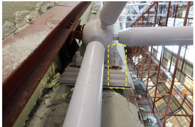
図 5.2.16 屋根支承部のアンカーボルトの伸び
