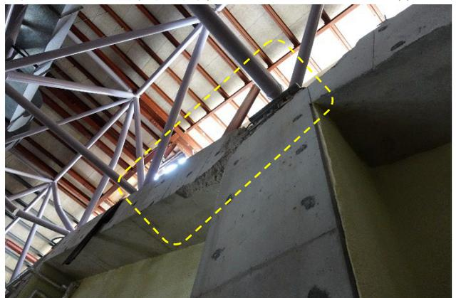
図 5.2.18 屋根支承部の接合部損傷
