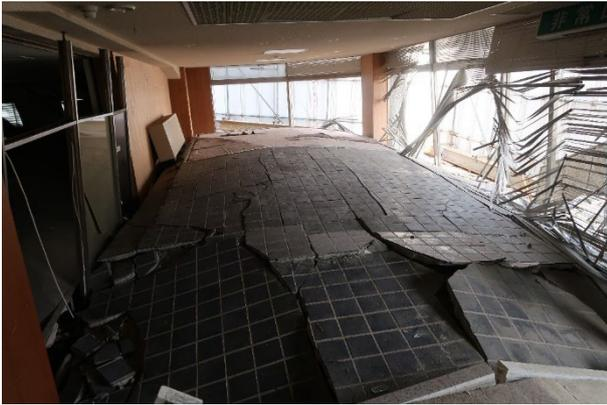
図 4.2.6 Y1~Y2 構面 1 階床の膨れ上がり
