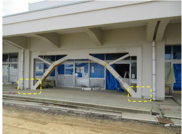
図 4.4.11 建築物 D-2 の鉄骨ブレース補強
