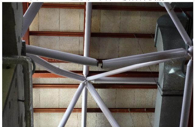
図 5.2.20 システムトラス屋根の主部材の座屈及び破断
