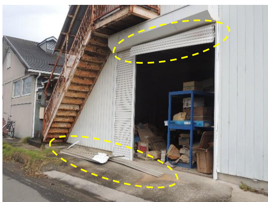
写真 3.7 シャッターの状況
