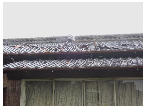
写真 3.2 屋根瓦の状況
