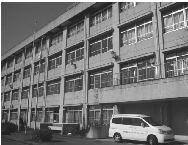
写真5-2 廃校後、コミュニティ施設として再生した「西永山複合施設」(永山地区、多摩ニュータウン)
