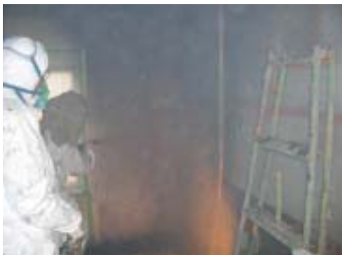
写真 3 施工時の状況（乾式工法）
