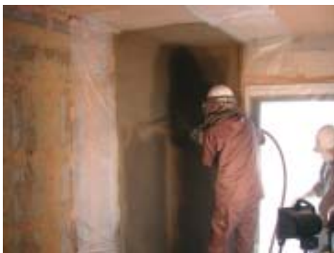
写真 2 施工時の状況（湿式工法）
